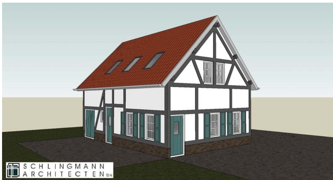
Figuur 32: De meeste huisjes die worden gebouwd zijn van dit type (102 stuks).
