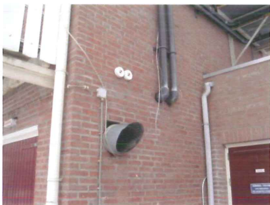
Figuur 13: De holten langs de ventilatiepijp zijn voor gebouwenbewonende vleermuizen een geschikte toegang tot de spouwen van het hoofdgebouw.
