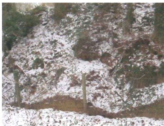
Figuur 18: Dassenpijp in het talud langs de holle weg aan de noordzijde van het bungalowpark.
