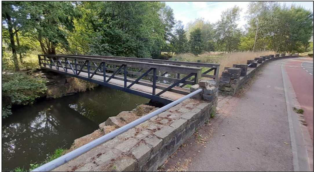
Voetgangersbrug over de Geul, aan de westzijde van het plangebied
