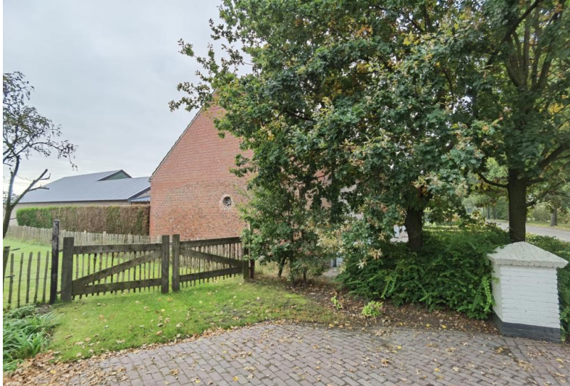
Foto van de blinde kopgevel van de schuur.
