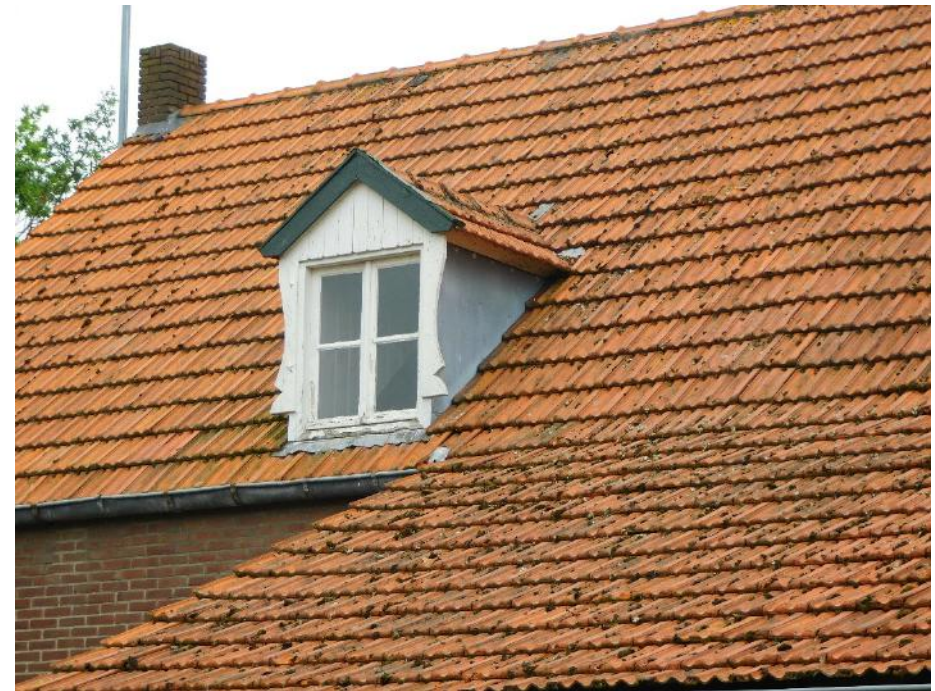
Figuur 20 - Houten dakkapel aan de achterzijde onder zadeldakje.
