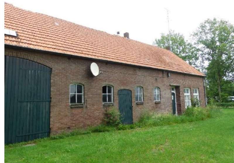
Figuur 21 - Overzicht voorgevel Heuvel 3, situatie juni 2021.
