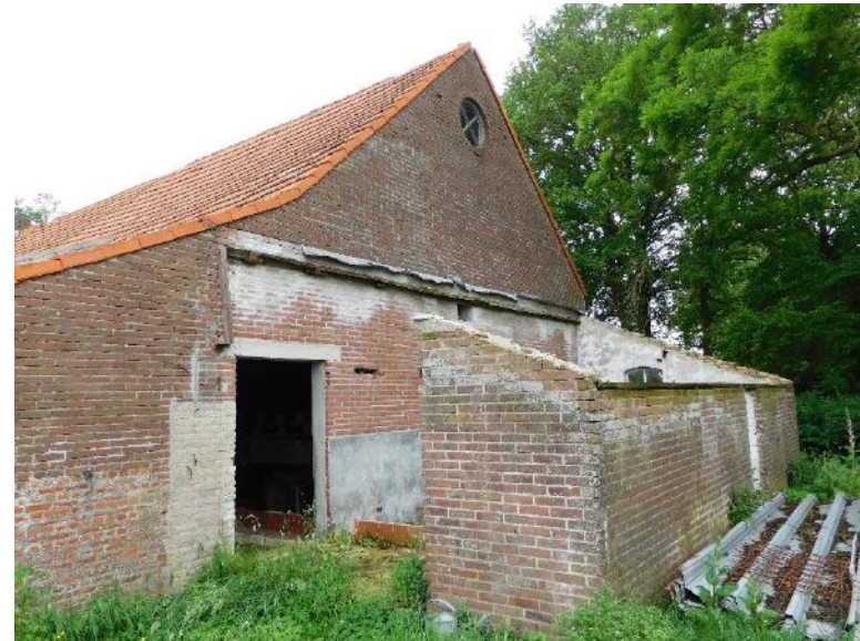
Figuur 13 - Linker zijgevel; in de top is een rond venster aanwezig.
