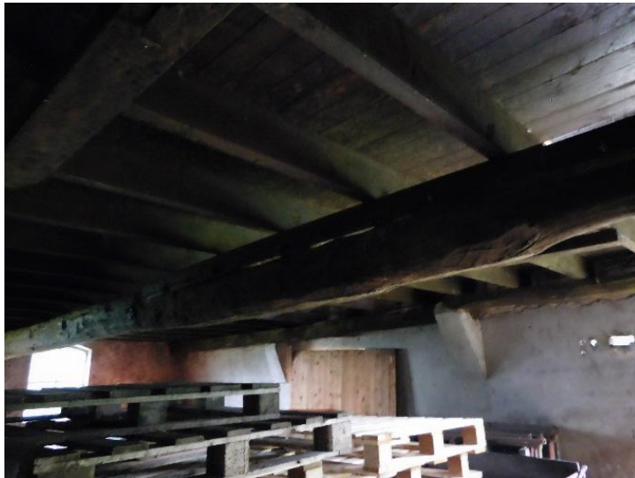
Figuur 14 - Interieur voormalige stal Heuvel 3, met hergebruikte draagbalk.
