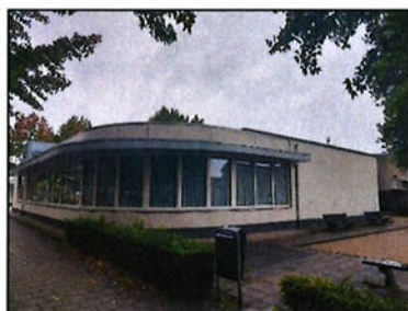
Figuur 2-4. Overzichtsfoto zaal op het zuidoosten. Kijkrichting Noordwest.
