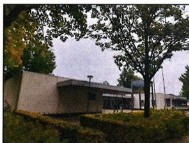
Figuur 2-3. Overzichtsfoto hoofdingang zuidzijde. Kijkrichting Noordoost.
