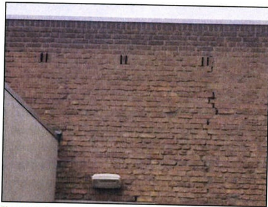
Figuur 5-2. Aanwezige open stootvoegen op de onderzoekslocatie geschikt voor bewonende vleermuizen.
