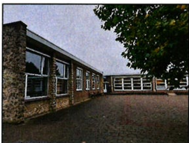
Figuur 2-3. Overzichtsfoto westzijde plein, kijkrichting noord.
