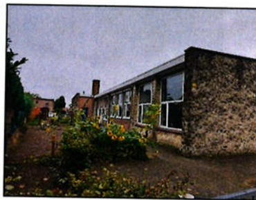
Figuur 2-8. Overzichtsfoto westzijde onderzoekslocatie, kijkrichting noord.
