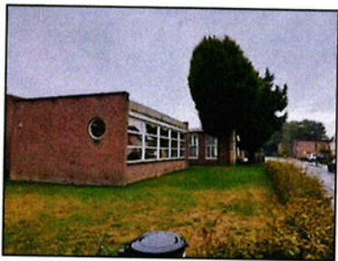
Figuur 2-6. Overzichtsfoto noordoostelijke hoekpunt bebouwing en gazon, kijkrichting west.
