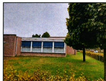
Figuur 2-5. Overzichtsfoto zuidoostelijke hoekpunt bebouwing en gazon, kijkrichting noord.
