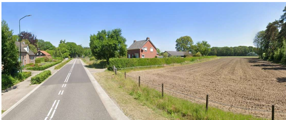
Bredasebaan in noordelijke richting, met rechts op de foto de bestaande woning Bredasebaan 10
