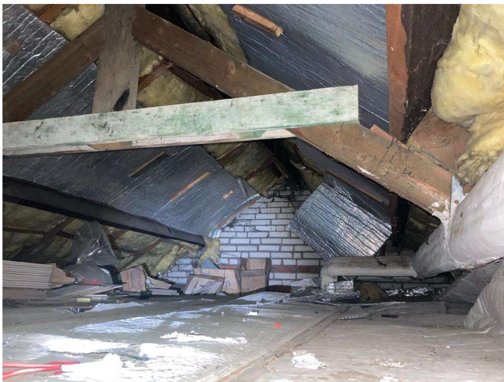
• Afbeelding 15: Zolder boven aangebouwd bijgebouw
