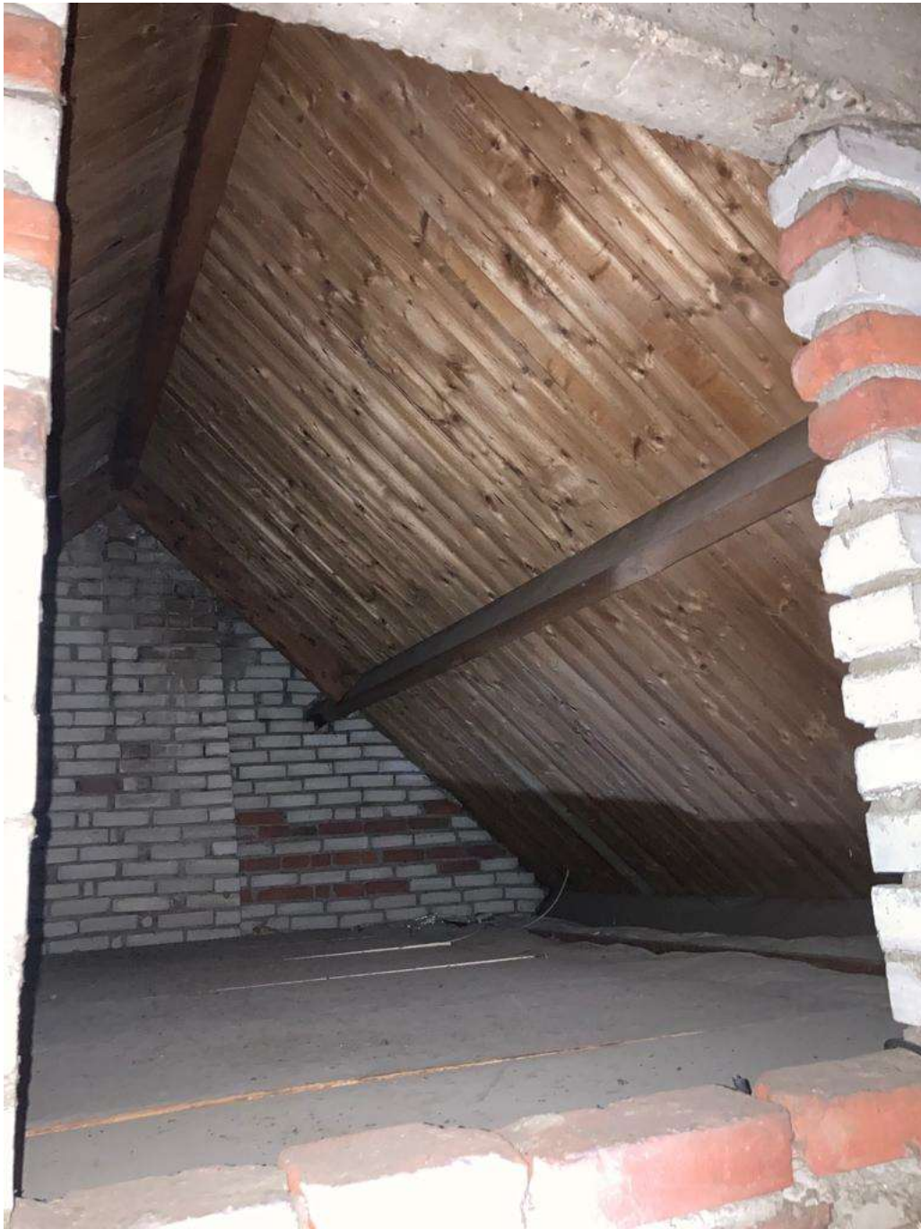
• Afbeelding 11: Zolder boven woonhuis, onderzijde dakpannen voorzien van dakbeschot.
