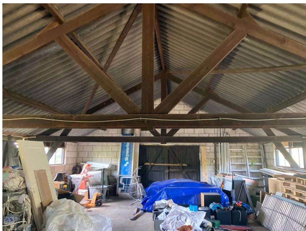
• Afbeelding 16: Binnenzijde bijgebouw, dak van ongeïsoleerde golfplaten
