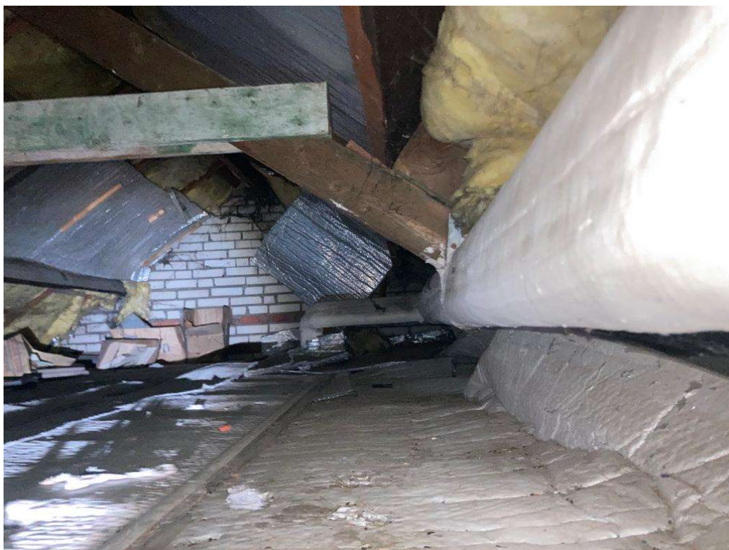
• Afbeelding 13: Zolder boven aangebouwd bijgebouw
