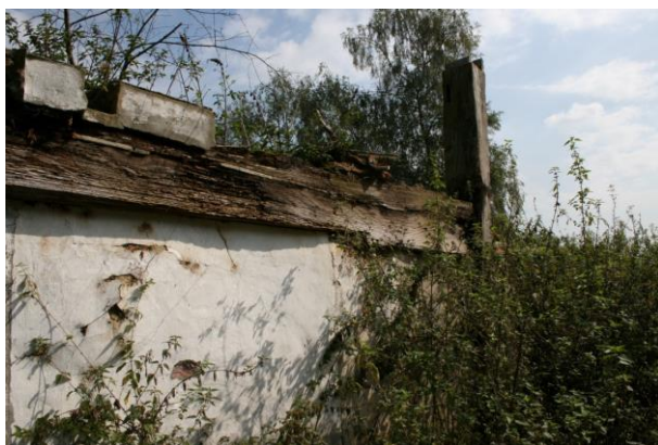
Ankerbalk met verdikking (mogelijk sleutelstuk)
