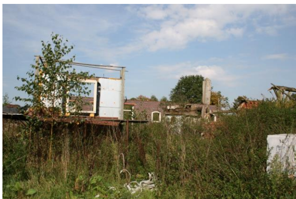
Nieuw gedeelte achtergevel
