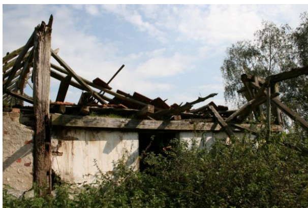
Oostelijke binnenmuur met tweede gebint
