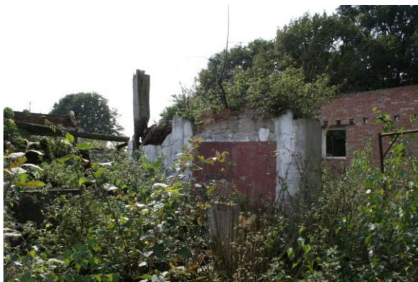
Westelijke binnenmuur met rood vlak
