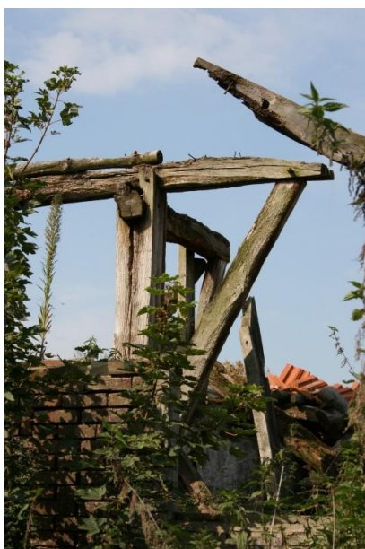
Tweede gebint vanaf de oostzijde. Mogelijk overstek en kopbalk. .
