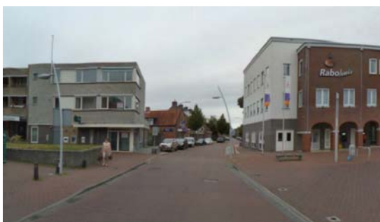
Noordwestzijde Markt met links het leegstaande voormalige Bankgebouw.
