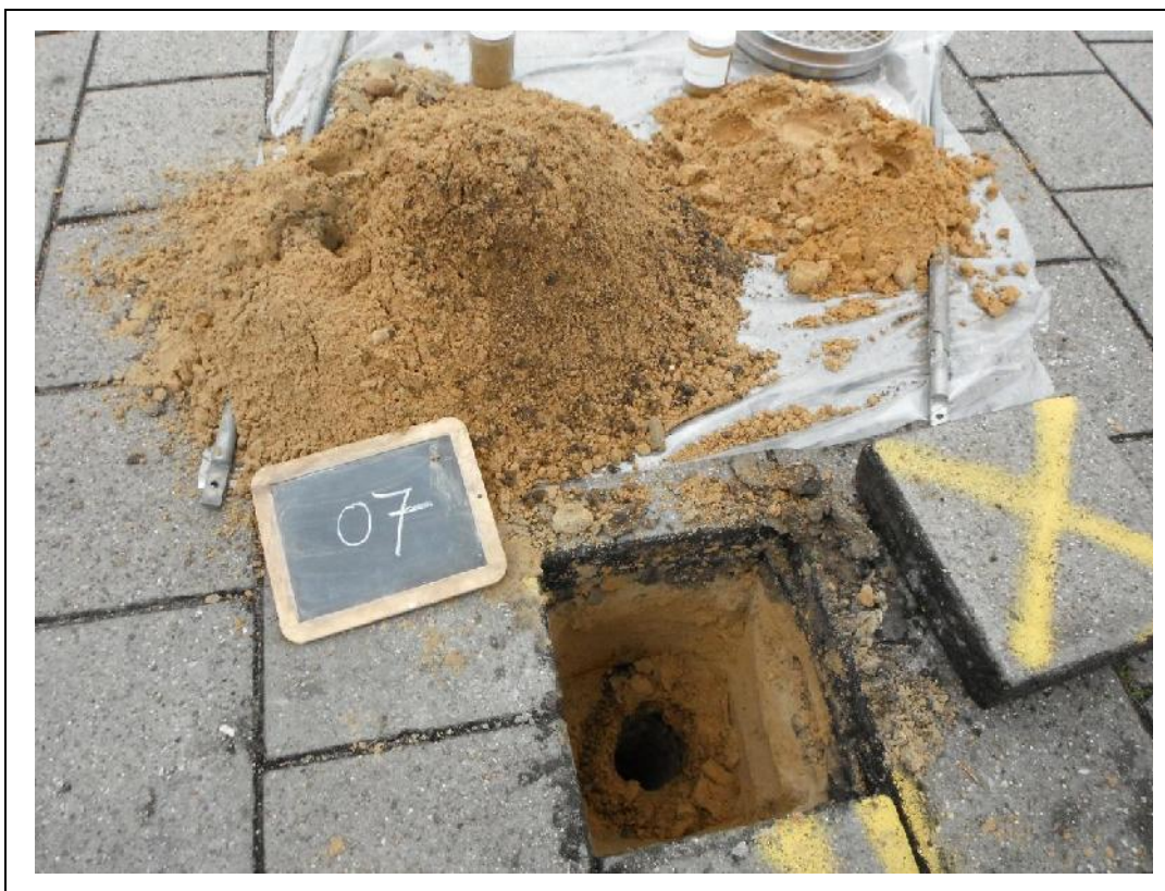
Foto 10. Asbestgat 7 en opgegraven en gezeefd materiaal asbestgat 7
