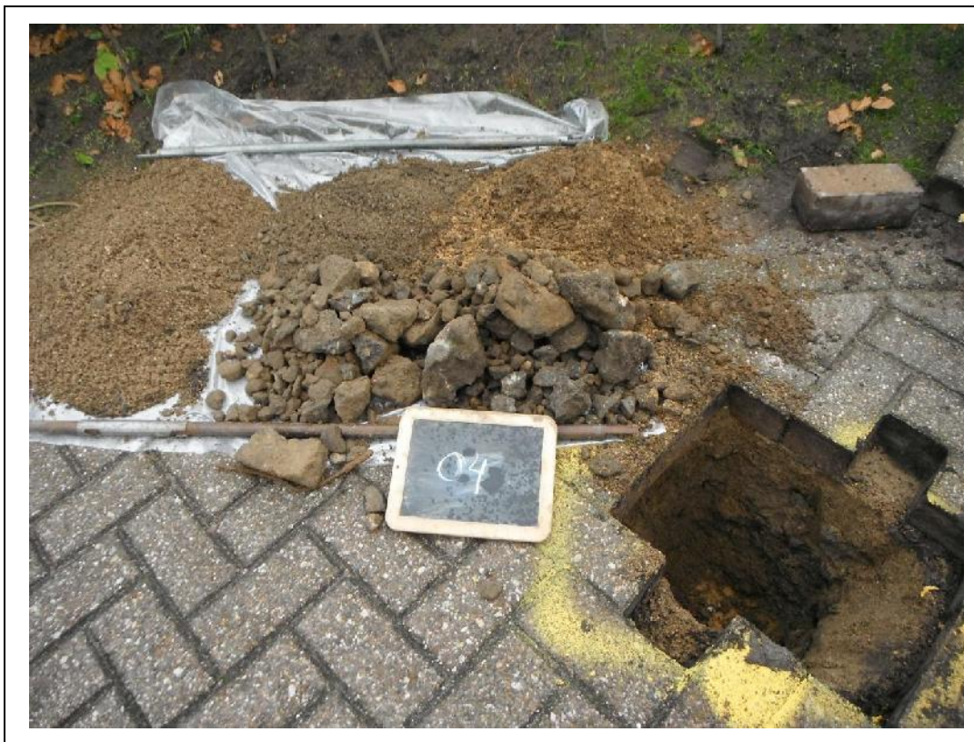
Foto 7. Asbestgat 4 en opgegraven en gezeefd materiaal asbestgat 4
