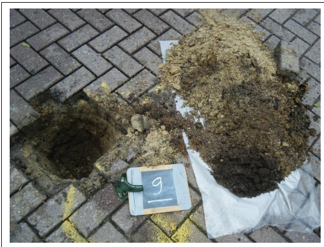
Foto 12. Asbestgat 9 en opgegraven en gezeefd materiaal asbestgat 9
