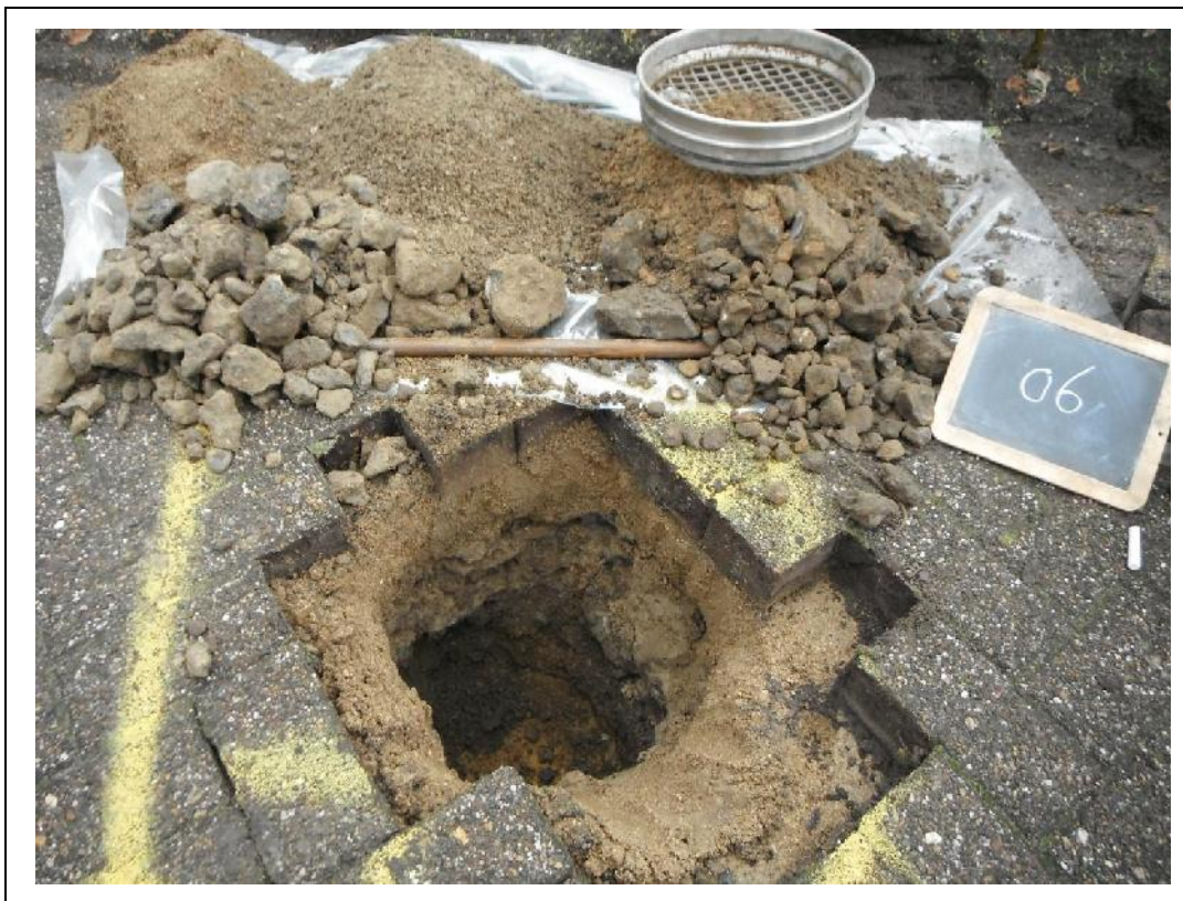
Foto 9. Asbestgat 6 en opgegraven en gezeefd materiaal asbestgat 6
