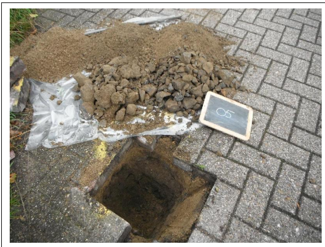
Foto 8. Asbestgat 5 en opgegraven en gezeefd materiaal asbestgat 5
