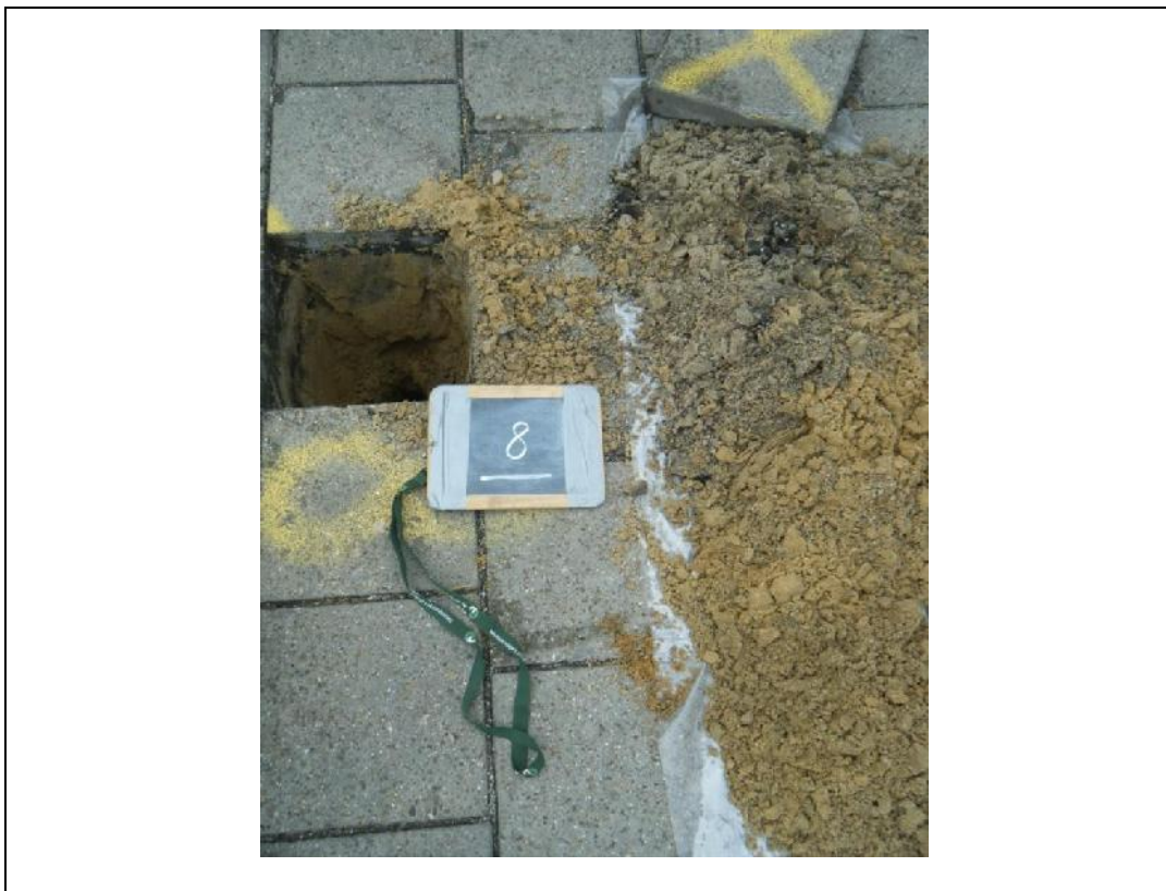
Foto 11. Asbestgat 8 en opgegraven en gezeefd materiaal asbestgat 8
