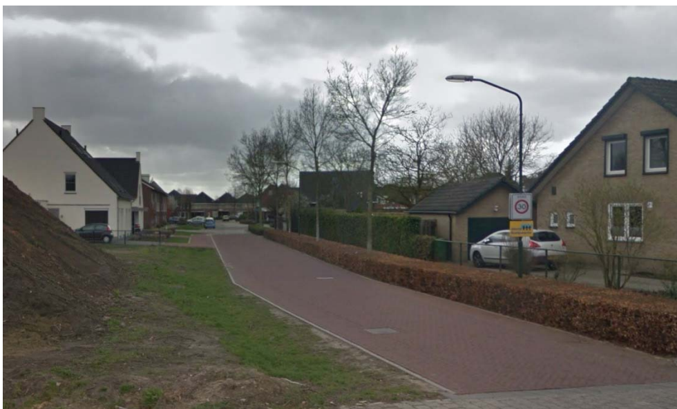
Het Kaar, gezien vanaf de Ganzestraat met rechts het groen van de achtertuinen en links bebouwing die de straat begeleidt. De bebouwing in het gebied is opgetrokken in 1 laag met kap.
