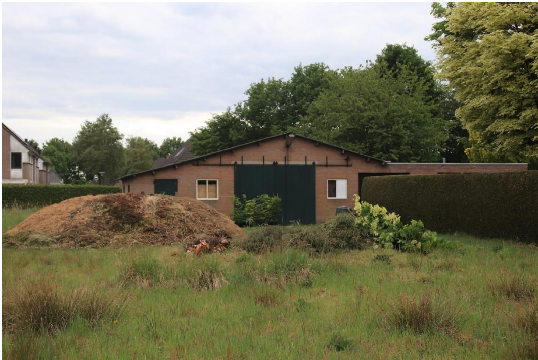
Foto 2: de schuur is totaal ongeschikt voor het vestigen van vleermuizen als vaste rust- en verblijfplaats
