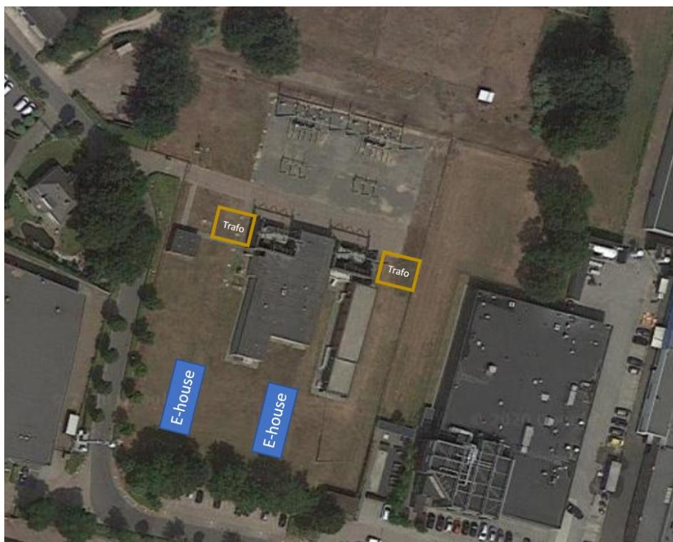
Figuur 1 Plangebied (in geel en blauw) ter plaatse van het Enexis-hoogspanningsstation aan de Zwartven in Hapert.
