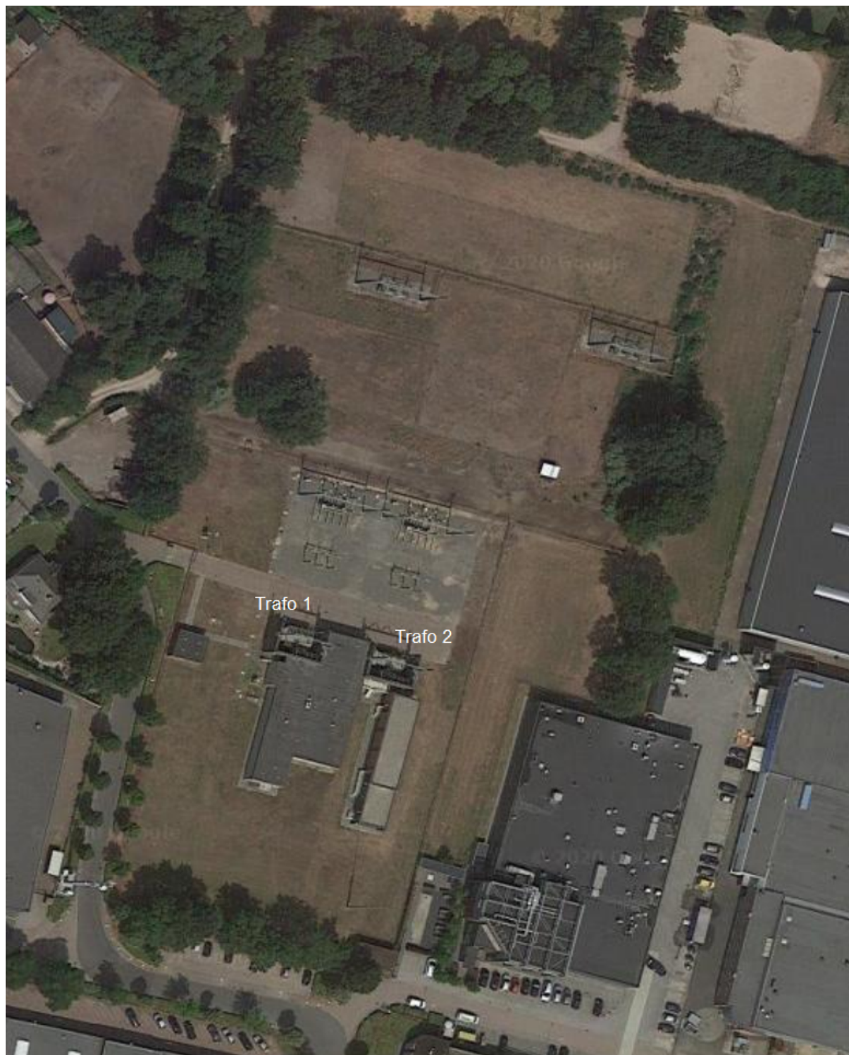
Afbeelding 3: Huidige situatie HS-station aan de Zwartven in Hapert
