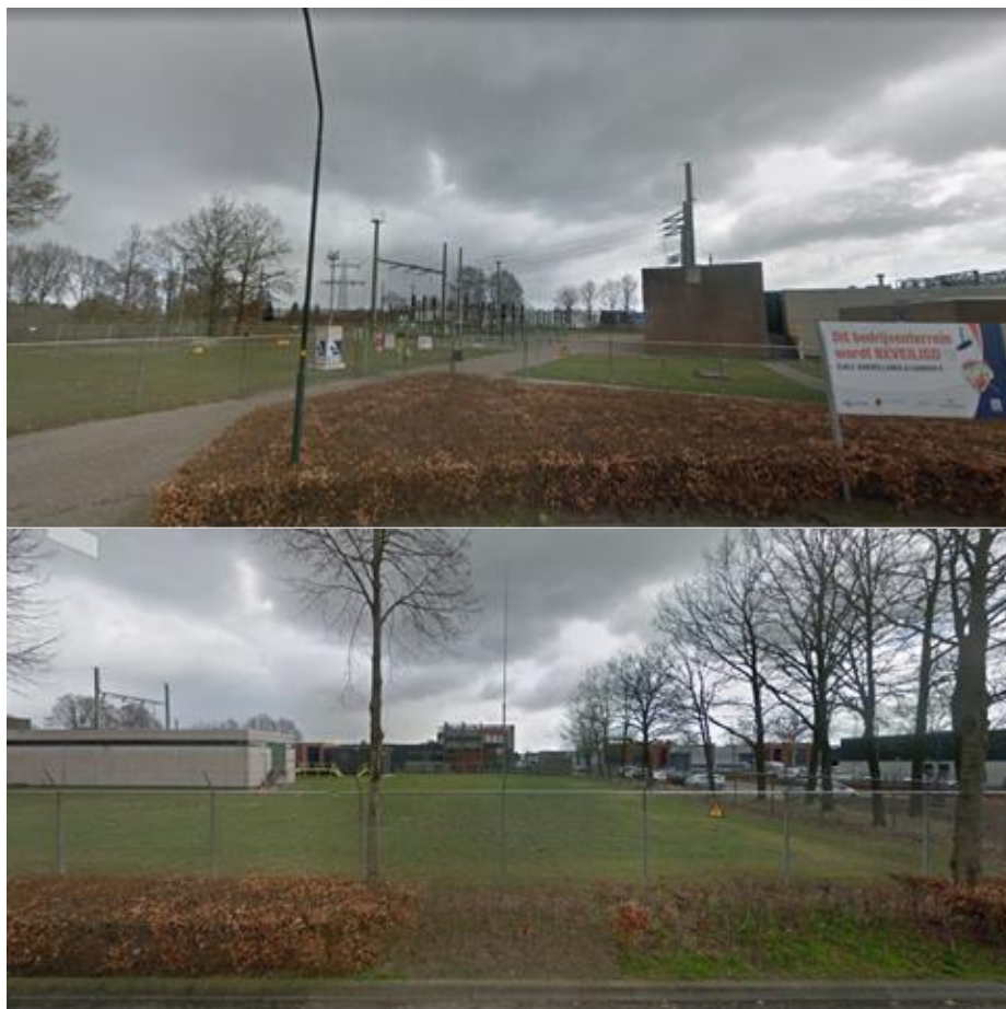
Figuur 2 Impressie van het plangebied, boven waar de transformatoren komen en onder waar de E-houses komen.
