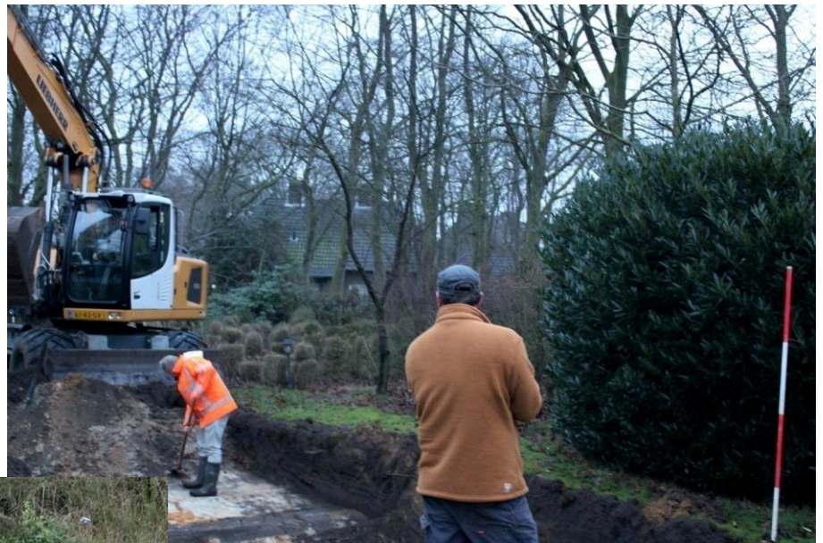
Fig. 4.2. Netersel Carolus-Simplexplein 3. Het aanleggen van het archeologische vlak.
