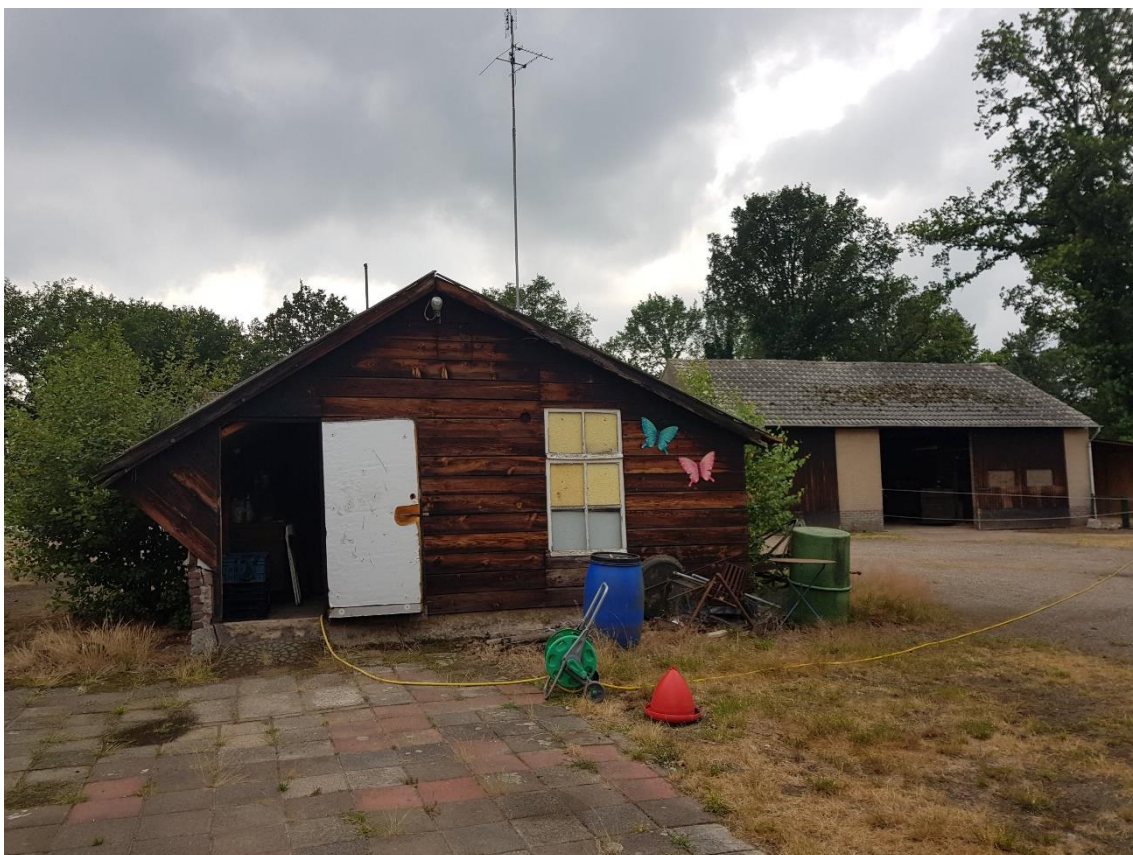
Figuur 8. Schuurtje bij oostelijke bedrijfswoning en achterin garage bij westelijke bedrijfswoning
