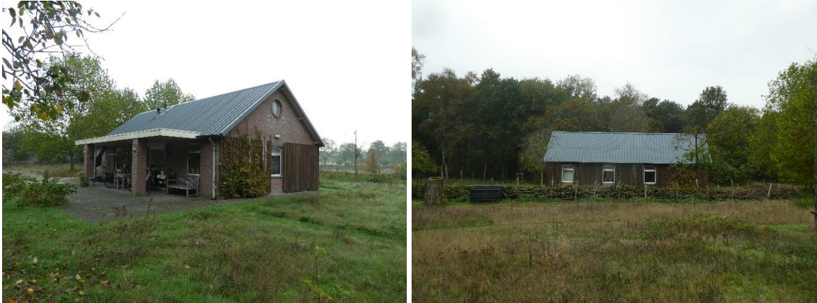
Afbeelding 7 en 8: Te slopen bebouwing. Bron: BNL advies. Datum: 31-10-2022
