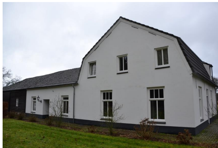
Het gestuukte deel van de linkerzijgevel.
