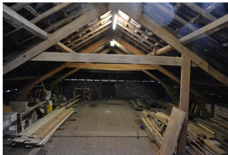
Kapconstructie van het vm. bedrijfs gedeelte.
