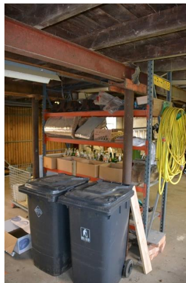
Links: interieur bedrijfs gedeelte met aangepaste draagconstructie. Rechts: het bouwspoor van de voormalige bakoven.
