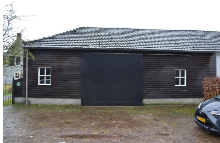
Het met hout beklede deel van de linkerzijgevel.
