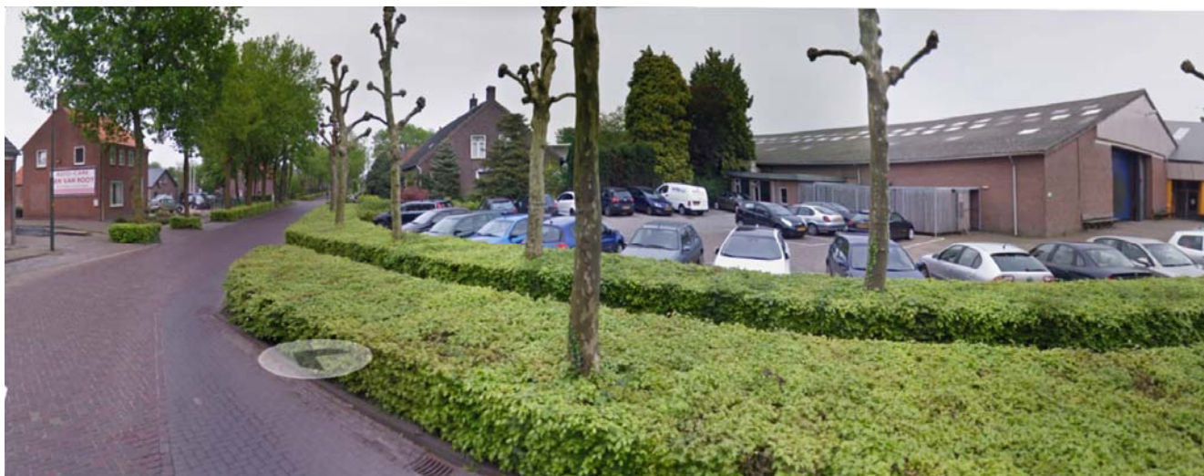
Gooskens Hout: het noordelijk bedrijfspceel, gezien vanaf de hoek Hoofdstraat-Breestraat
