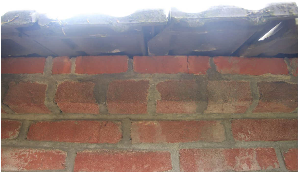
Foto 2: Er zijn geen mogelijkheden voor huismussen om nesten te maken onder de pannen, door de dakconstructie terplekke van de buitenmuur
