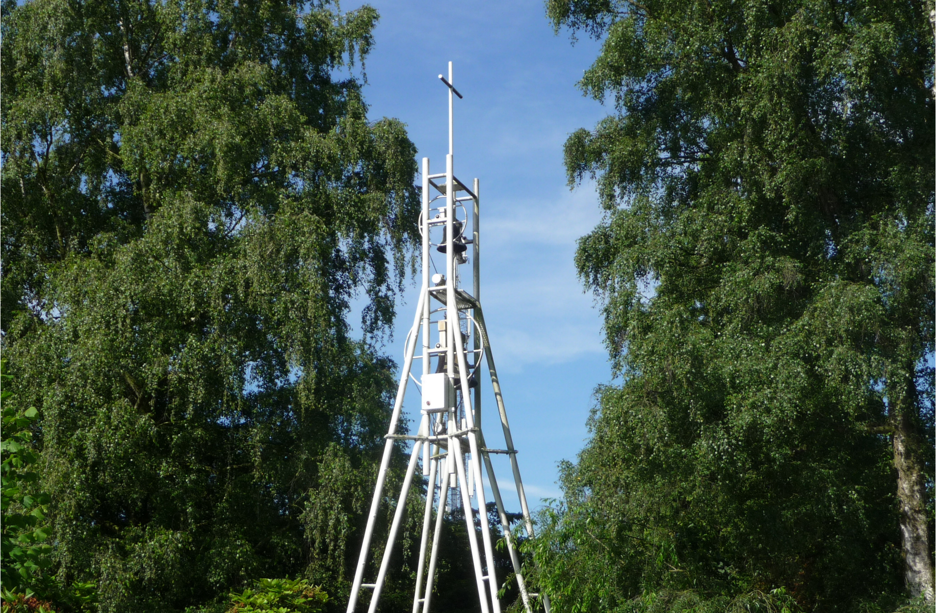
Klokkenstoel met Severinusklok en Donatusklok in de tuin van de pastorie.
