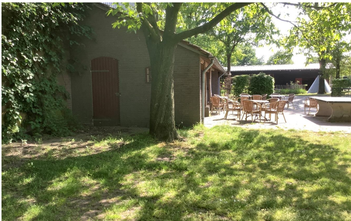
Foto van de onderzoekslocatie (uitbreiding groepsaccommodatie – d.d. 9 mei 2022)
