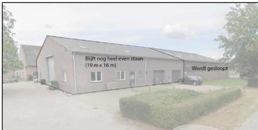
Afbeelding 4: Tijdelijk te behouden deel van bedrijfsgebouw
