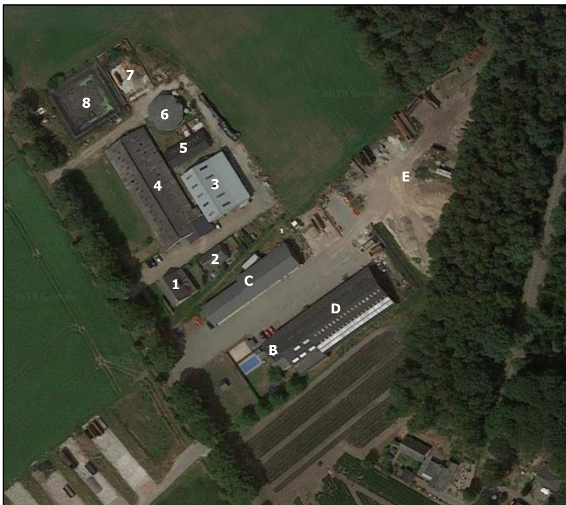
Afbeelding 1: Luchtfoto bestaande situatie Schotelven 3 en 3a
