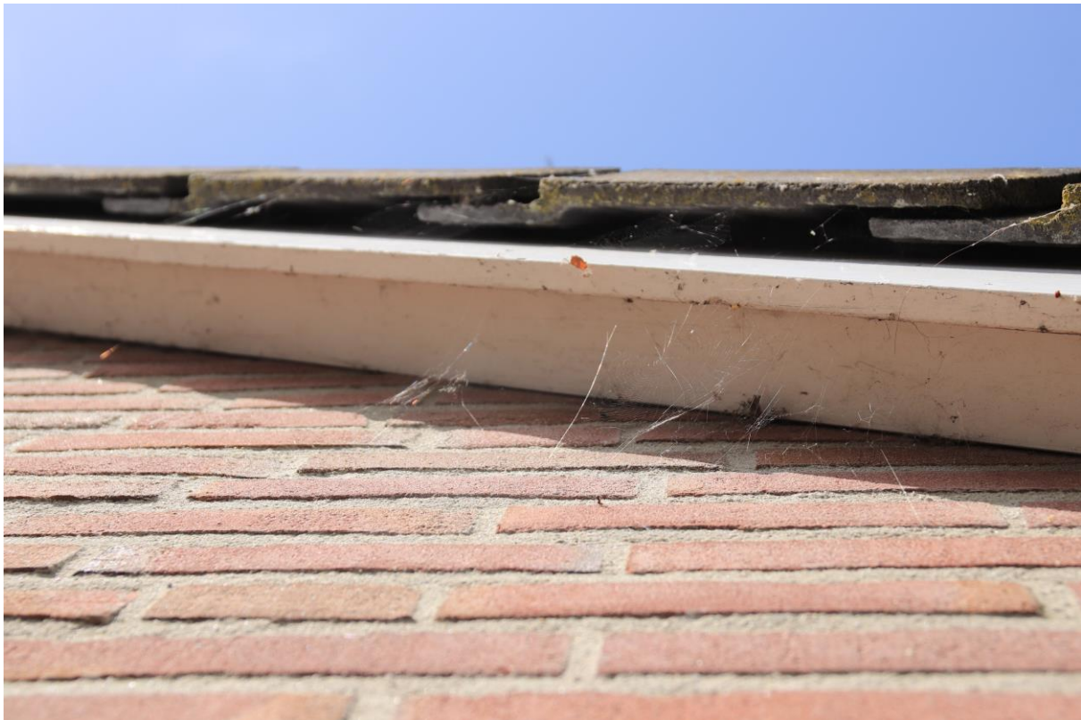
Het plaatwerk zit zeer strak tegen de muur en er zit nagenoeg overal spinnenweb
