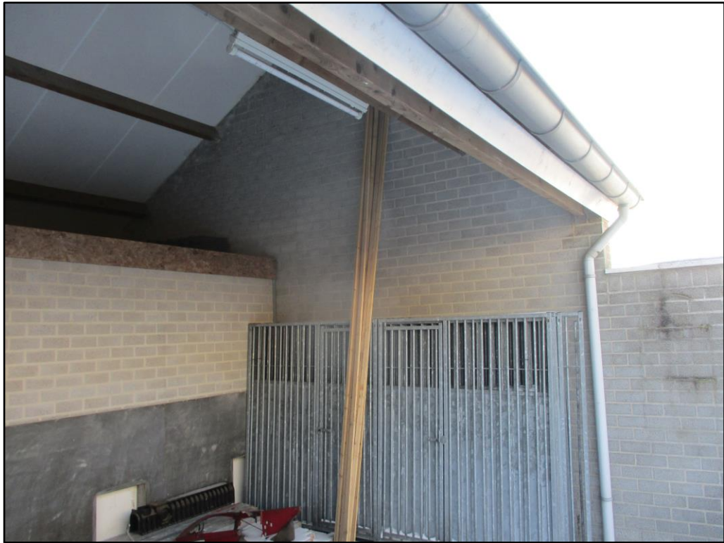
Figuur 3 Overzicht van de binnenzijde van een van de overkappingen op de planlocatie.
