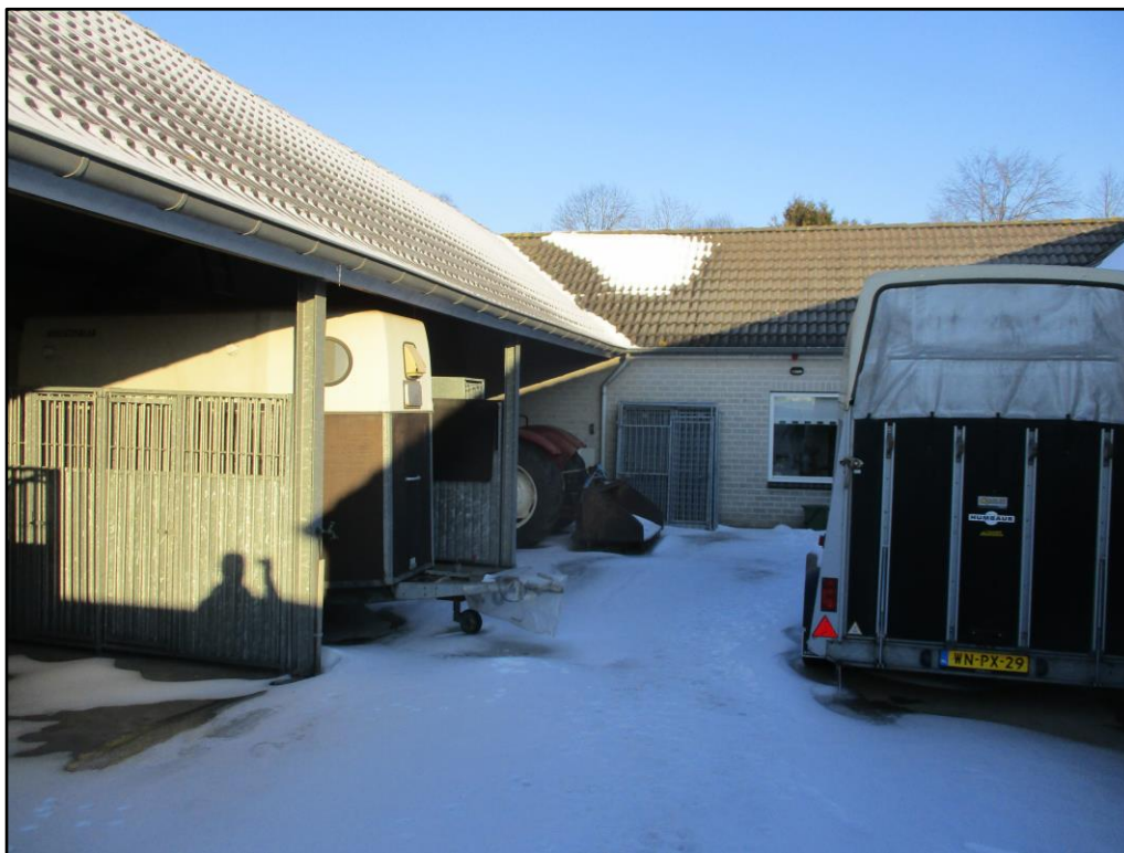
Figuur 2 Overzicht van de 'binnenplaats' van het U-vormige gebouw op de planlocatie.
