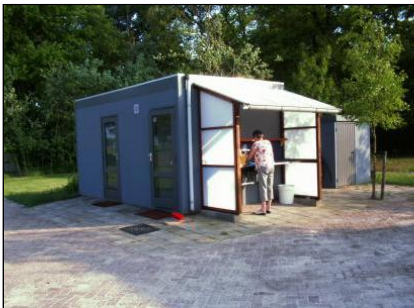
Afbeelding 3: Bestaande sanitair-unit en buitenkeuken
