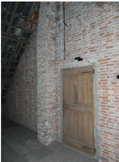
76. Brandmuur met links van het rookkanaal het trapluik. JvL 2015.
