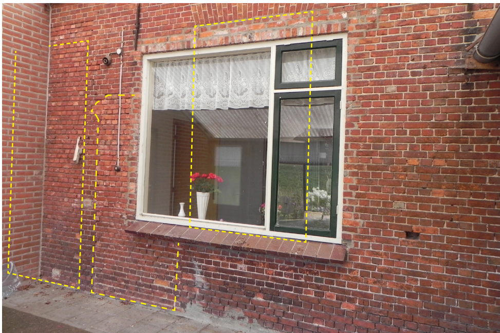
40. Delocatie van de openingen in de oorspronkelijke voorgevel. Ertussen een bouwspoor dat duidt op een latere toegang. JvL 2015.
