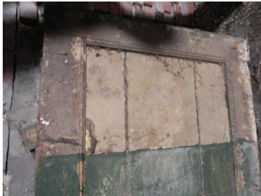
87. De losse deur op de zolder toont onder het groen de originele kleurstelling. JvL 2015.
