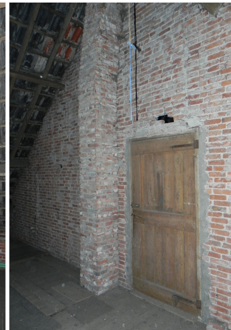
60. Brandmuur aan de woonhuiszijde. JvL 2015.
