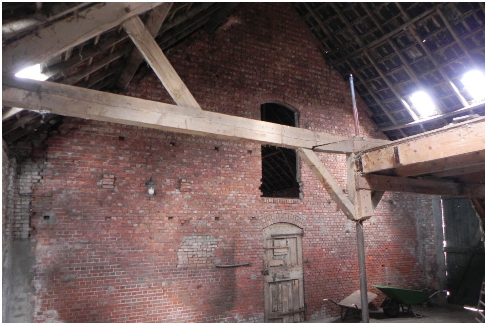
39. De oorspronkelijke westgevel is nu een binnengevel. JvL 2015.
