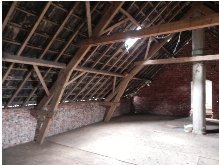
61. Verbeterde Holland spanten op de zolder boven de stal. JvL 2015
