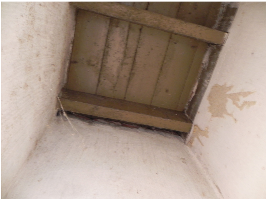
55. Boven de keldertoegang is de originele balklaag te zien. JvL 2015.
