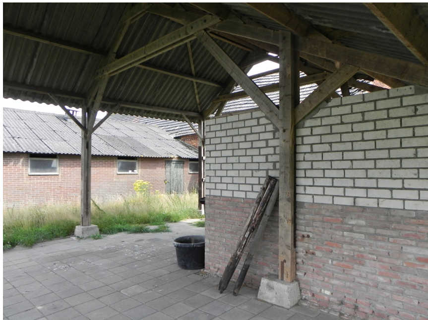
31. Interieur van de open kapschuur, gebouw 2. JvL 2015.
