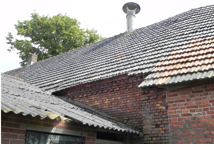
50. De aansluiting van bouwdeelen 1a, 1b en 1d. Op de nok de vormgegeven asbesthoudende ventilatievoorziening JvL 2015.
