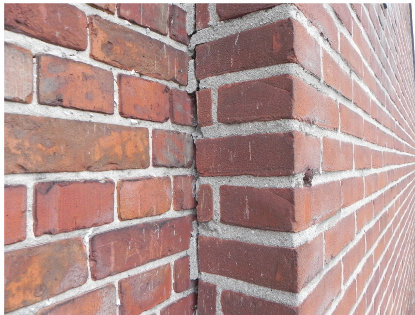
53. De aansluiting van bouwdeel 1e op 1a (links).
