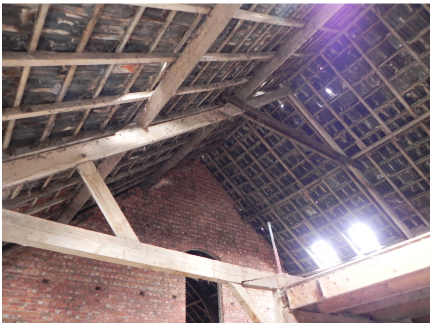
63. Constructie van bouwdeel 1b. JvL 2015.
