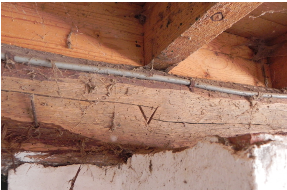
58. Ingemetselde balk met telmerk V. JvL 2015.
