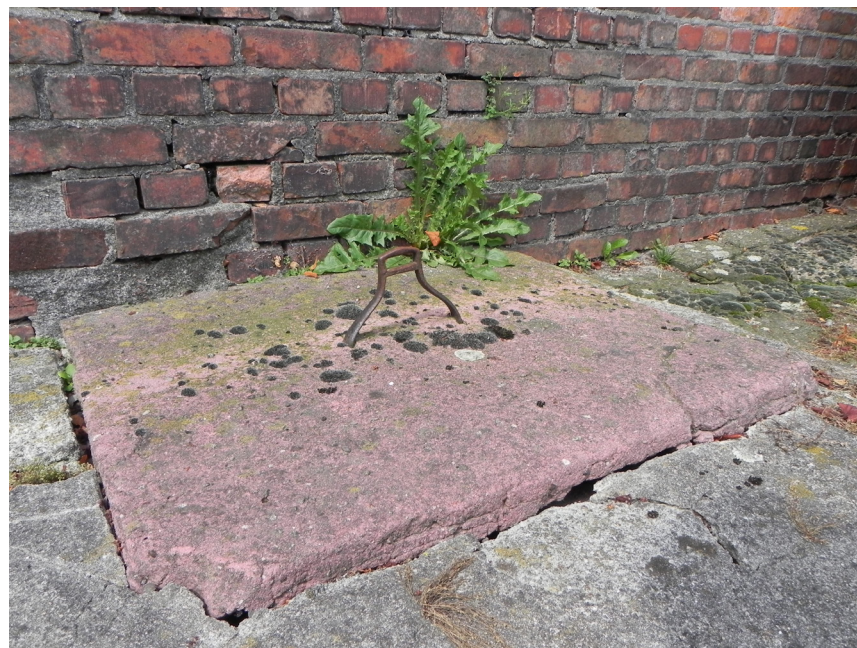
54. Afdekplaat van de gierput. JvL 2015.
