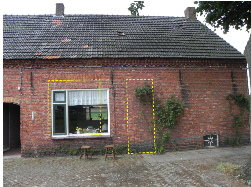
36. Zuidgevel met de oorspronkelijke gevelopeningen ingetekend. In het rechter vlak is de oorspronkelijke keukendeur te herkennen. JvL 2015.
