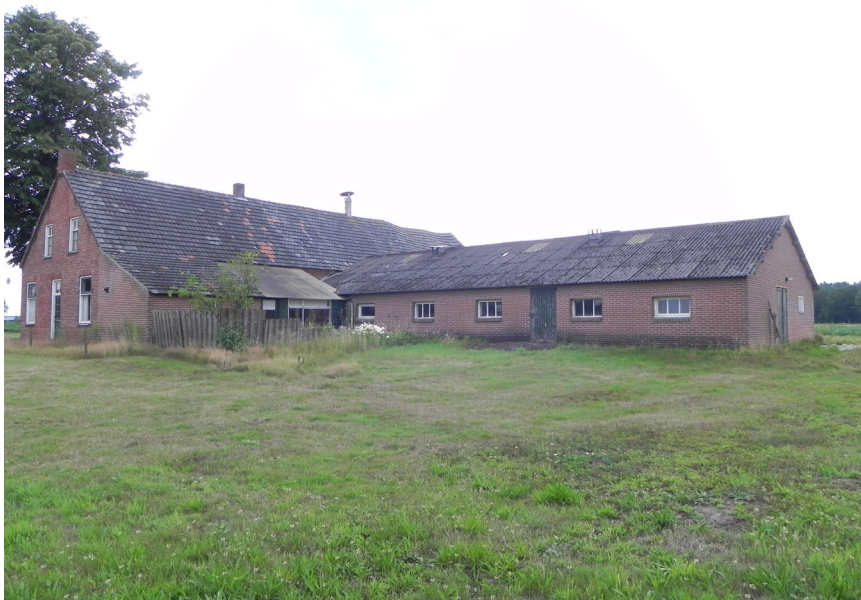
18. Zicht op oude voorgevel waartegen een portaal, overkapping en stal gebouwd zijn. JvL 2015.
