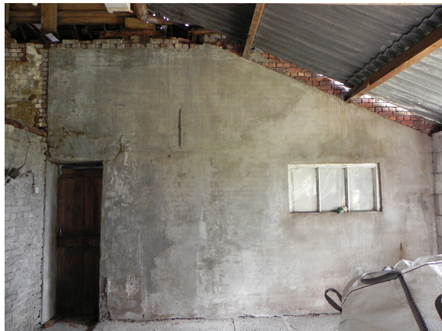
42. De noordgevel in de stal 0.14 met afleesbaar een dichtgezette deuropening. JvL 2015.
