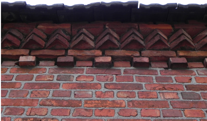
37. De combinatie van een bloktand en muizentandfries. Het grijze voegwerk is een latere aanpassing. JvL 2015.
