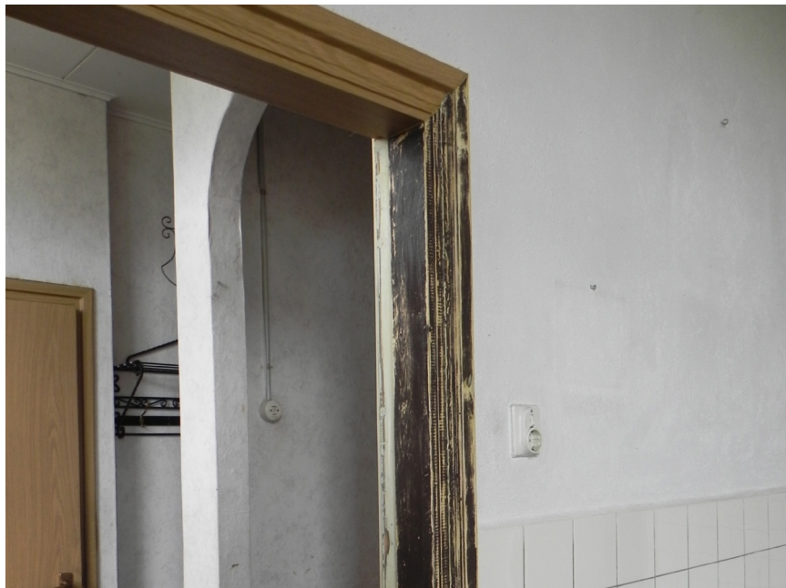
73. Onder de folie zitten nog mooie originele kozijnen. De architraven of koplatten zijn jonger. JvL 2015
