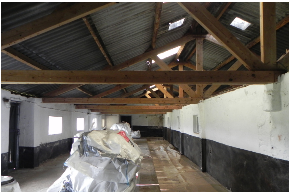
65. Oude stal met nieuwe dakconstructie. JvL 2015.
