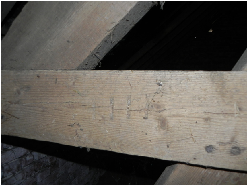
62. Telmerk III op blokkeel van spant. JvL 2015
