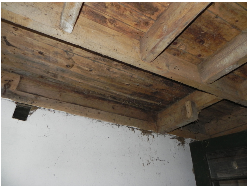
80. Het plafond van portaal 0.08 laat een oude trapopgang zien. JvL 2015
