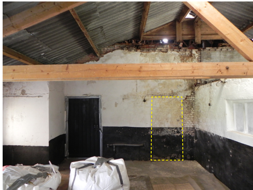
41. De noordgevel in de stal 0.13 met afleesbaar en dichtgezette deuropening. JvL 2015.
