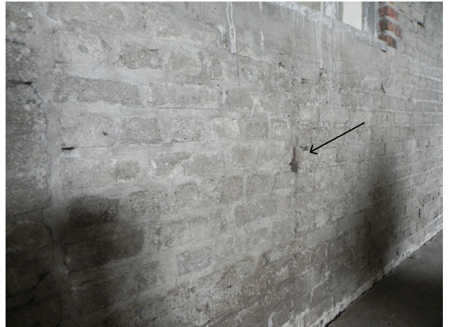
84. Dichtgezette varkensdeurtjes. De pijl geeft een gehengduim aan. JvL 2015
