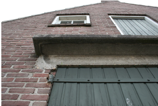
Latei en luifel van beton
