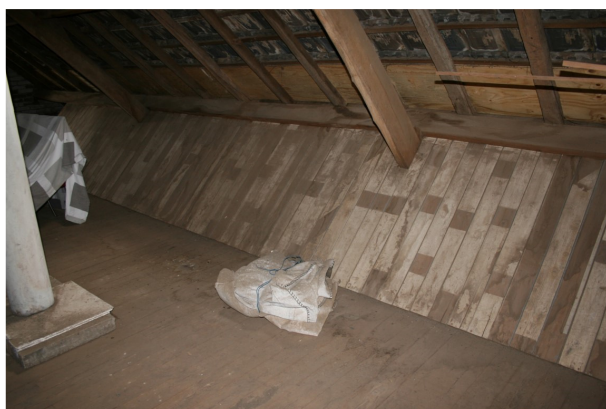
Aftimmering ter plaatse van de lichtstrook
