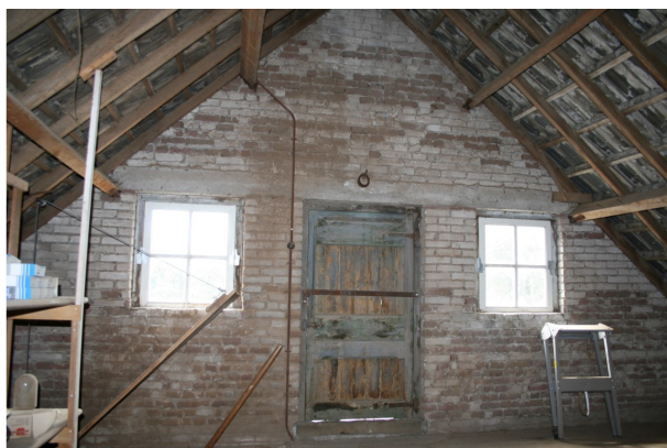
Voorgevel aan de binnenzijde
