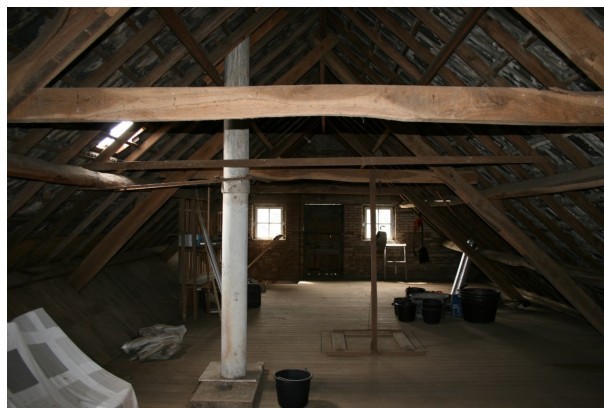
A-spanten op zolder
