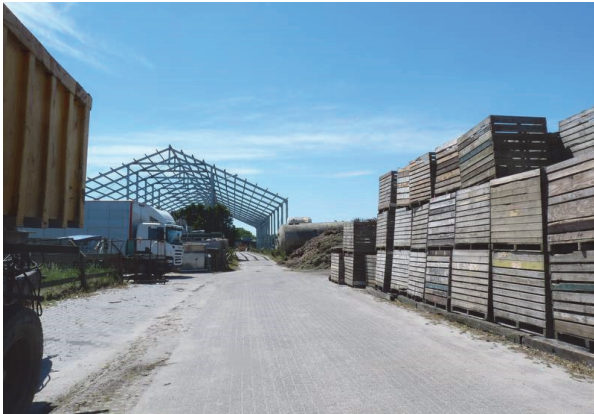
Fig. 3. Overzicht van het plangebied. Foto genomen in westelijke richting vanaf het Rond Deel.
