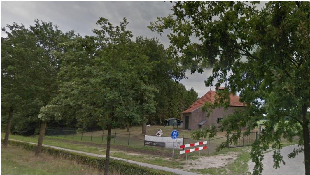
Figuur 5.1 Foto van de huidige situatie, genomen vanaf N284 met de verhoging en sloot in beeld
