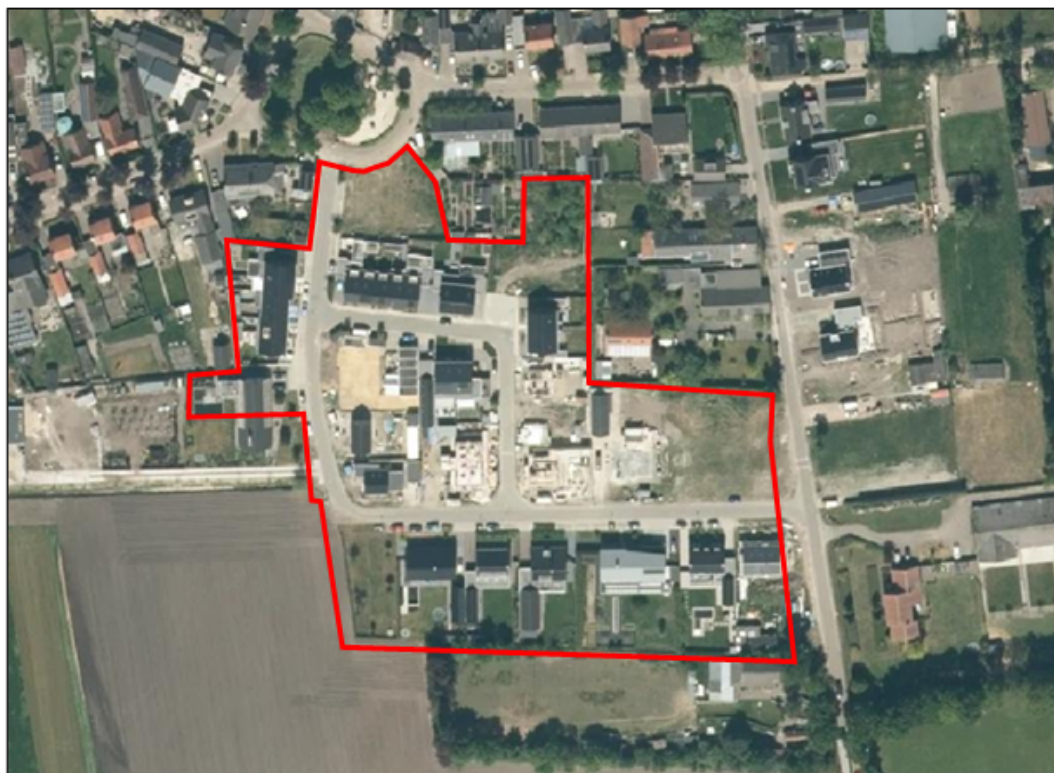
Luchtfoto locatie. Het plangebied is met een rode contour aangeduid. Bron: www.ruimtelijkeplannen.nl , 2022
