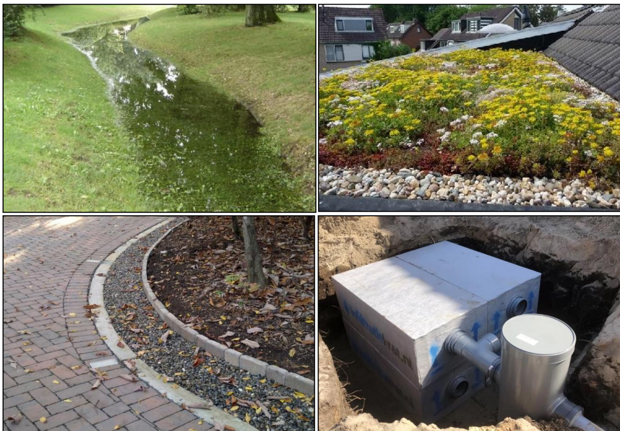
Figuur 14: mogelijkheden infiltratievoorzieningen (vlnr: wadi, groendak, grindkoffer en infiltratiekratten)
