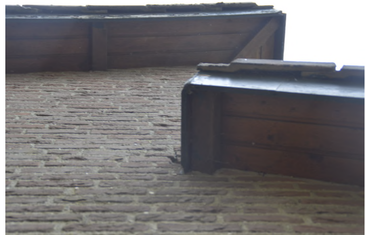
overstek linkerzijde woning
