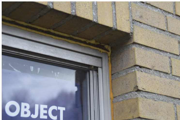
afgedichte raamkozijnen
