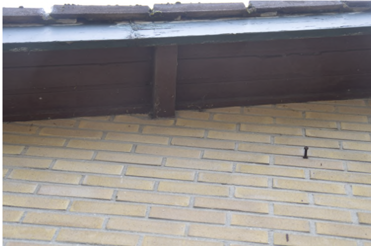
dichte aansluiting overstek / muur
