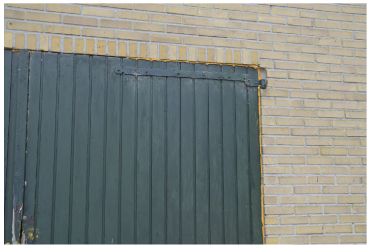
afgedichte deur garage
