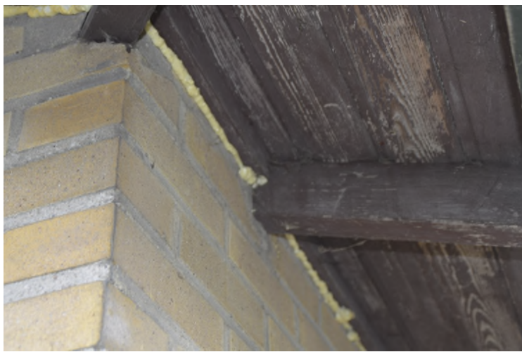
afgedichte aansluiting dak/muur
