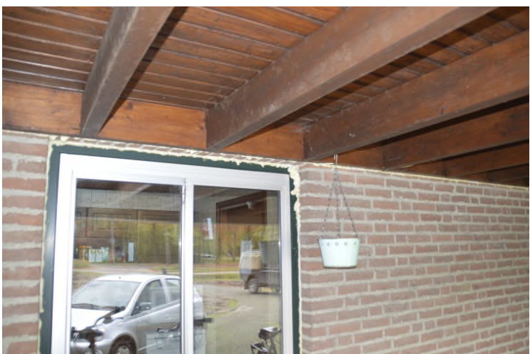
afgedichte raamkozijnen
