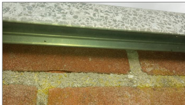
Afbeelding 5.1 | Detail van de afwerking van het platte dak van de carport.
