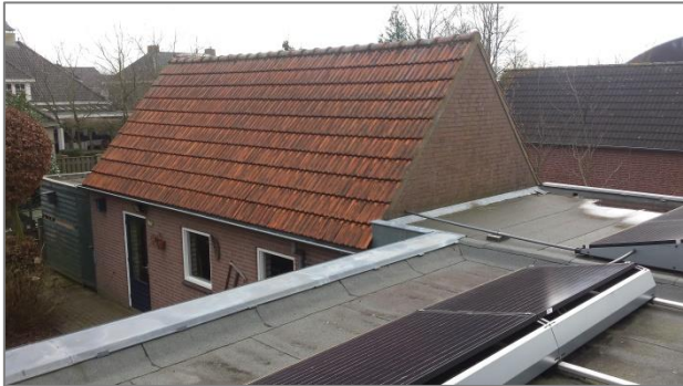
Afbeelding 2.3 | Zicht op de schuur vanaf het dak.
