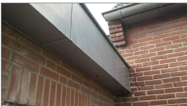
Afbeelding 2.7 | Detail van de dakrandafwerking van de carport aan de achterzijde.
