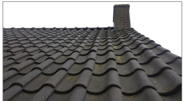
Afbeelding 2.6 | Detail van het dak en de schoorsteen van het hoofdgebouw.
