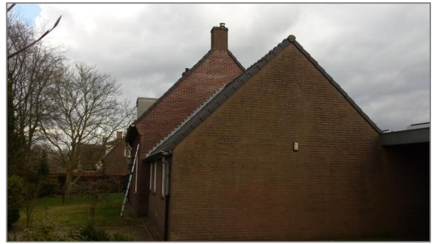
Afbeelding 2.2 | Zicht op de kopgevel van het hoofdgebouw.
