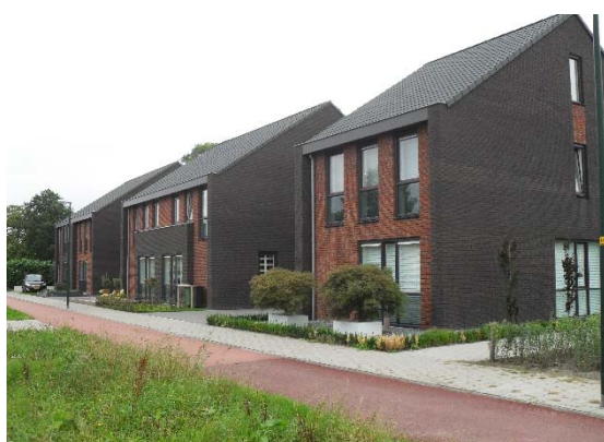
Nieuwe woningen aan de zuidzijde van de Gozelinusbocht tegenover het initiatief
