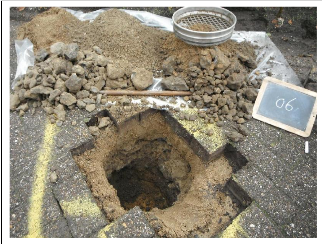
Foto 9. Asbestgat 6 en opgegraven en gezeefd materiaal asbestgat 6
