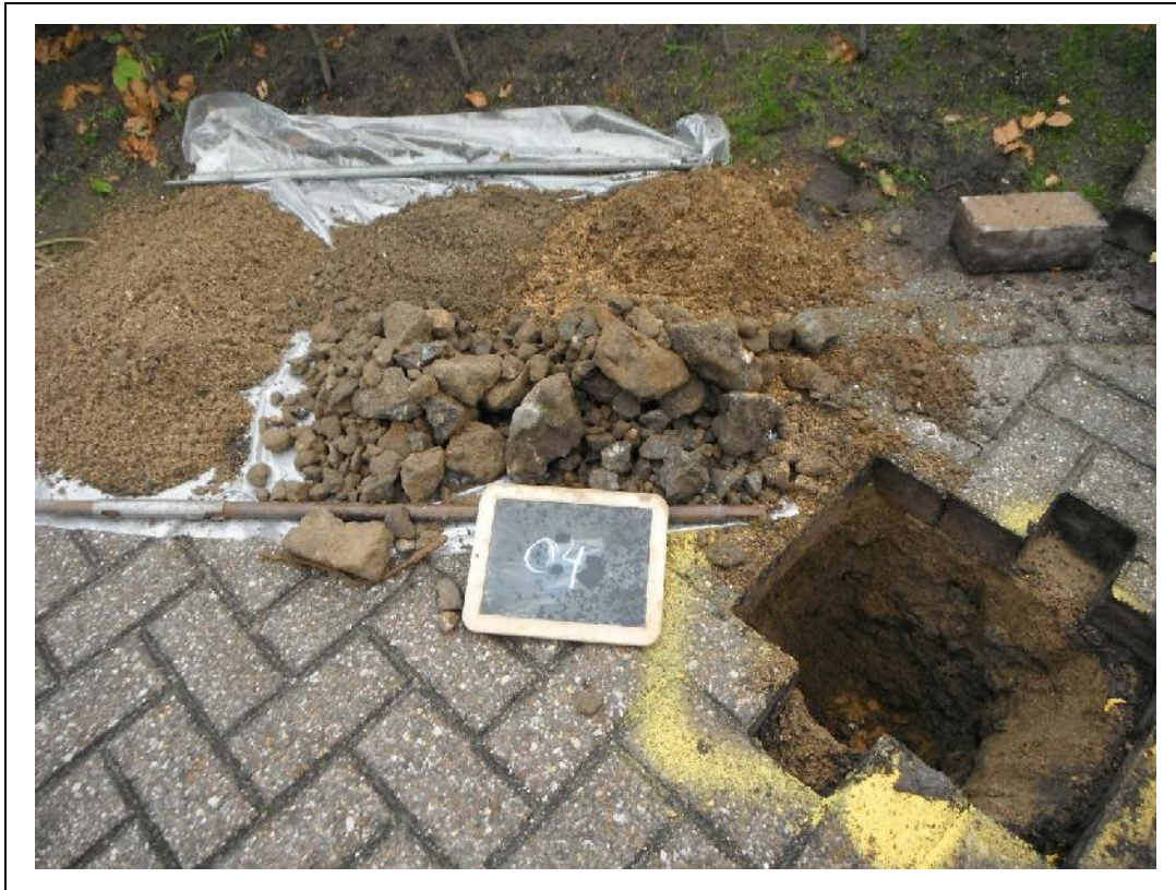
Foto 7. Asbestgat 4 en opgegraven en gezeefd materiaal asbestgat 4
