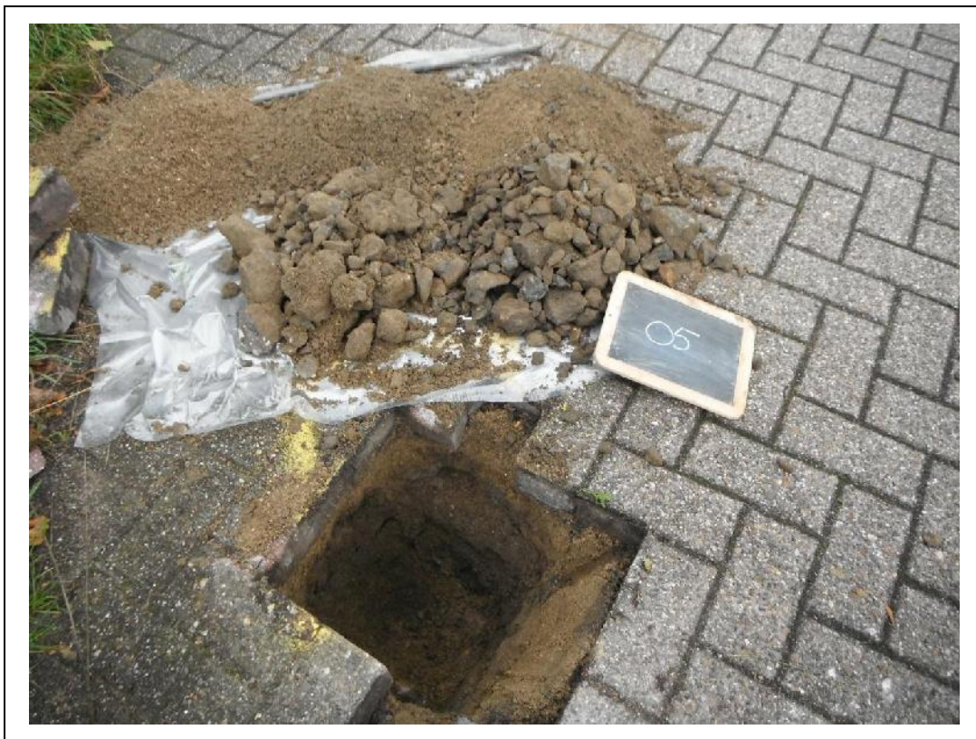
Foto 8. Asbestgat 5 en opgegraven en gezeefd materiaal asbestgat 5
