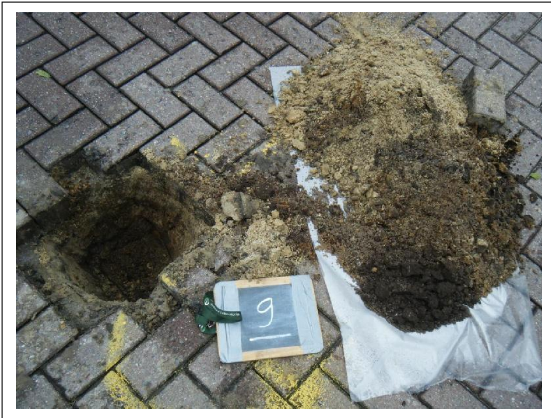
Foto 12. Asbestgat 9 en opgegraven en gezeefd materiaal asbestgat 9
