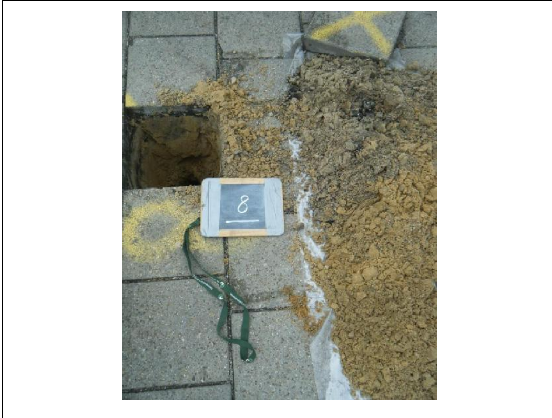
Foto 11. Asbestgat 8 en opgegraven en gezeefd materiaal asbestgat 8
