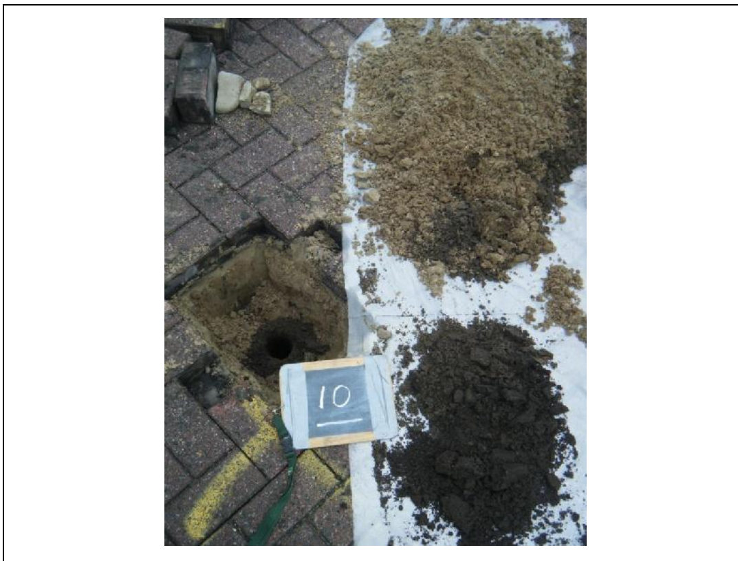
Foto 13. Asbestgat 10 en opgegraven en gezeefd materiaal asbestgat 10
