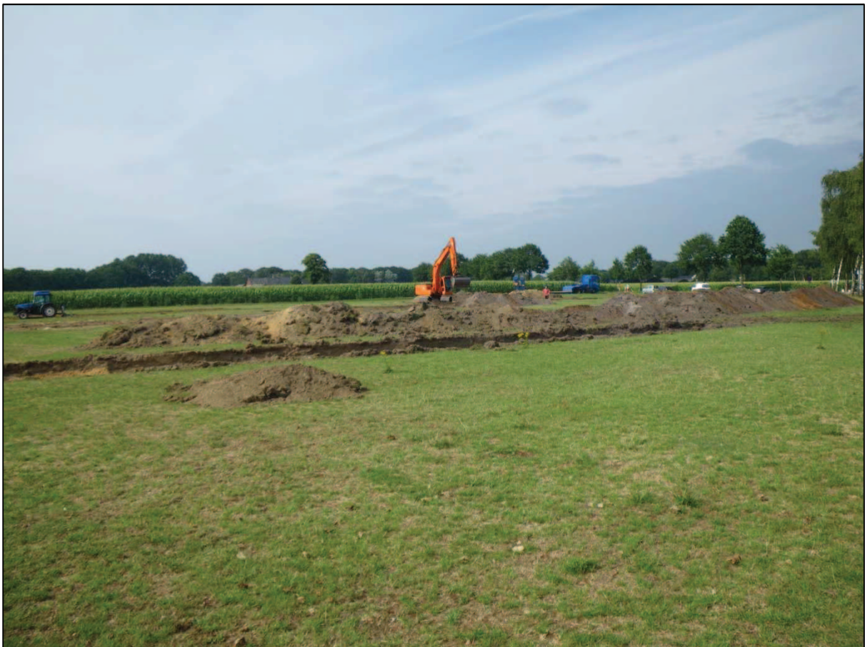
Figuur 2: sfeerfoto van de werkzaamheden.
