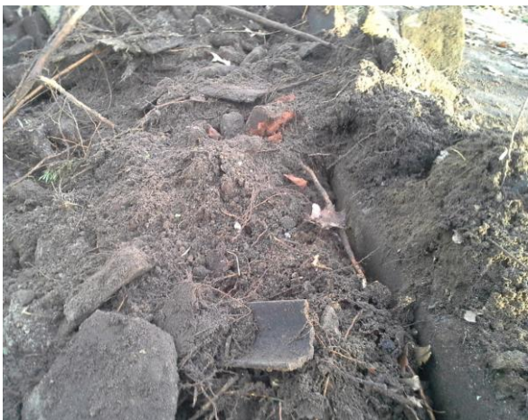
foto 2+3: fragmenten asbest tevens verwerkt in funderingsbalk
