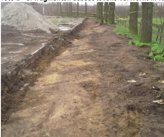
foto 2+3: fragmenten asbest tevens verwerkt in funderingsbalk
