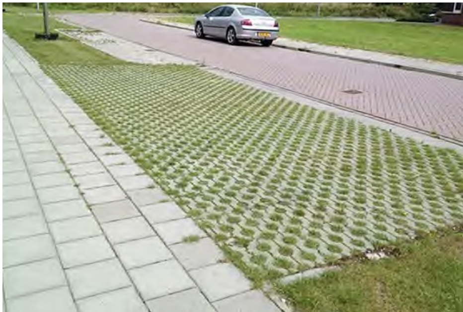
Ter plaatse van bermstroken worden inritten uitgevoerd in grastegels
