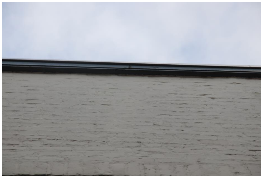
Foto 1: onder de dakafwerking zijn geen mogelijkheden voor broedvogels om zich te vestigen, de afwerking is strak tegen de bakstenen gemaakt.
