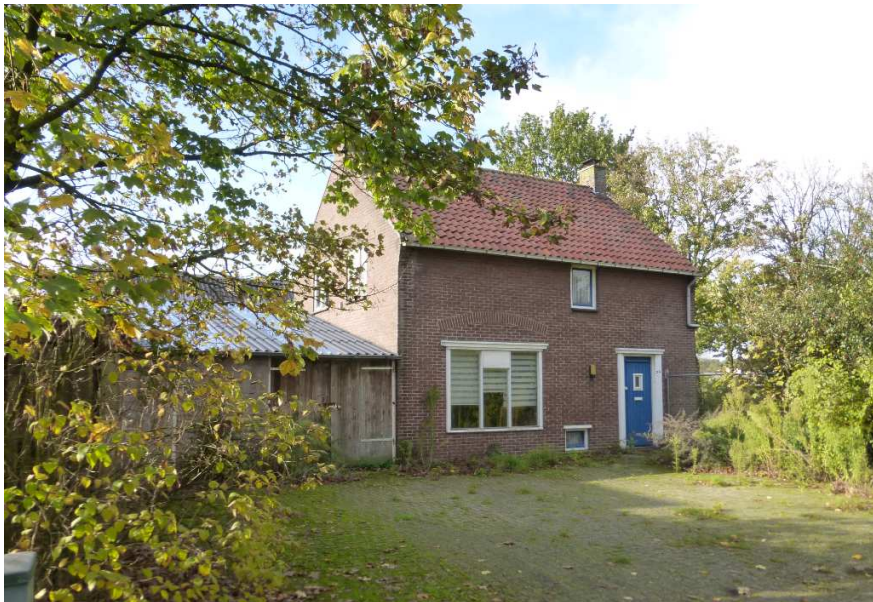
Figuur 8: Beeld van de huidige, te slopen bedrijfswoning binnen het plangebied
