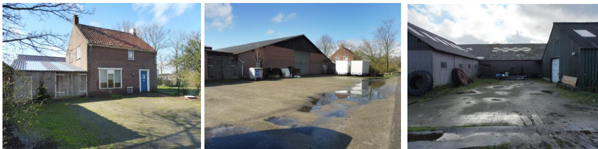
Zicht op het te slopen bedrijfswoning en bedrijfsgebouwen vanuit de Lage Berkt en zicht op het erf vanuit de Weebosserweg.
