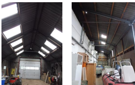
Binnenzijde van de slopen schuur/werkplaats en de voormalige champignonkwekerij.
