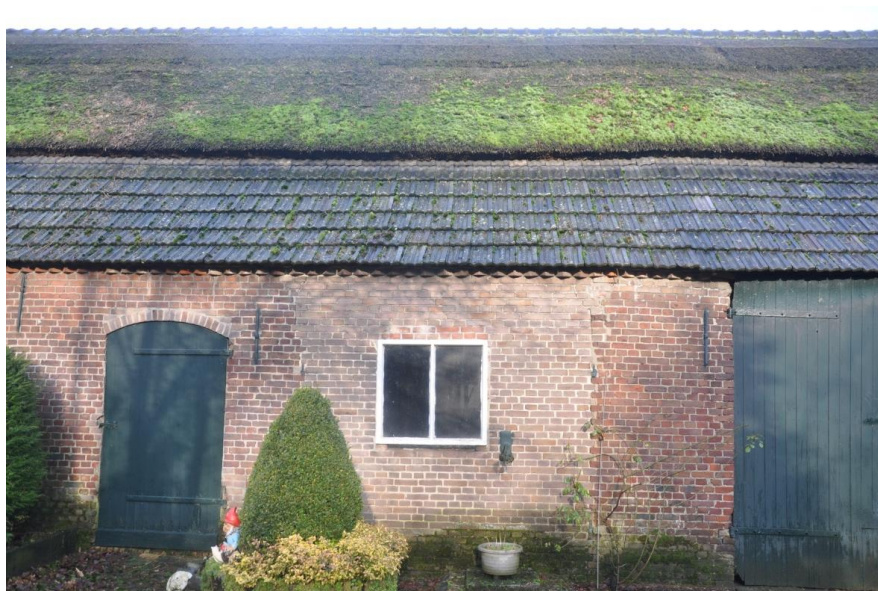
Afb.7. Zuidgevel stalgedeelte met mestdeur en dichtgemetselde deuropening van de voormalige potstal.
