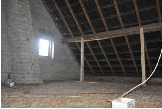
Afb. 51. dakconstructie met schaarspanten.
