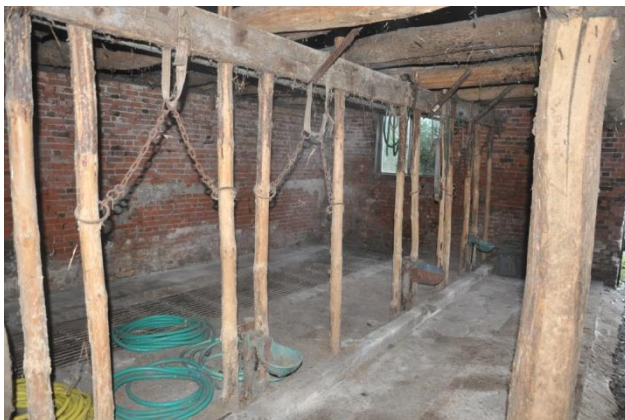
Afb. 34. Koeienstal met roosters in voormalige tasruimte.
