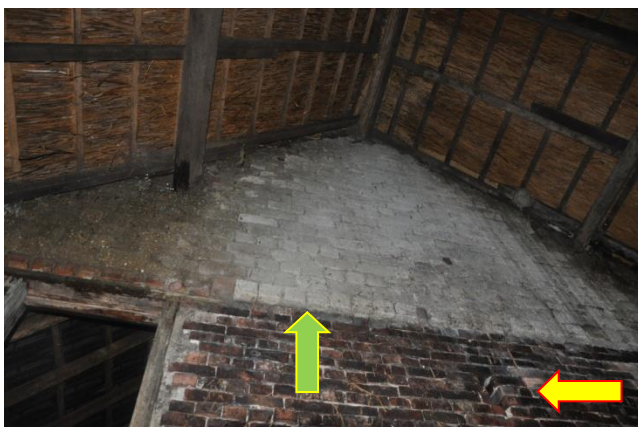
Afb. 10. Oorspronkelijke eindgevel binnen de groene pijl geeft de hoogte aan van het eindschild de gele het uilengat. ( De deuropening is bij de bouw van de tweede woning gemaakt).
