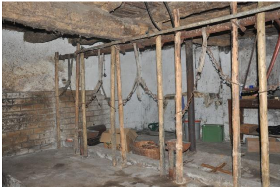
Afb. 32. Stalrepels en moerbalk met slieten zoldering Afb. 33. Recentelijk van stal afgescheiden berging.
