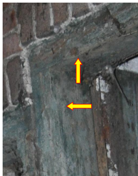
16. Detail kozijn naar paardenstal.
