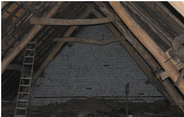
Afb. 57. Brandgevel(kalkzandstenen).
