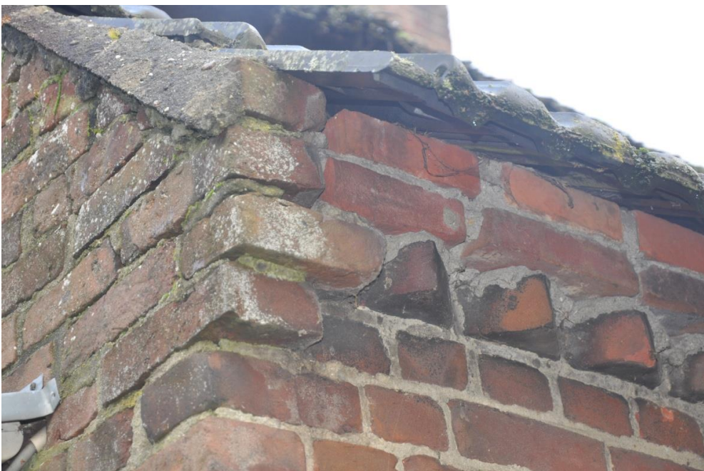
Afb.12. Hoek dak-zuidgevel woongedeelte (herkenbaar de overgang gevel muizentand) .
