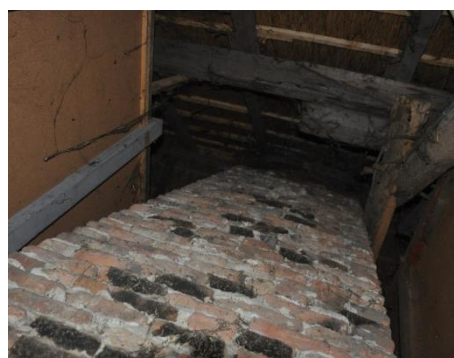
Afb. 31. Rookkanaal tussen gang en slaapkamer
