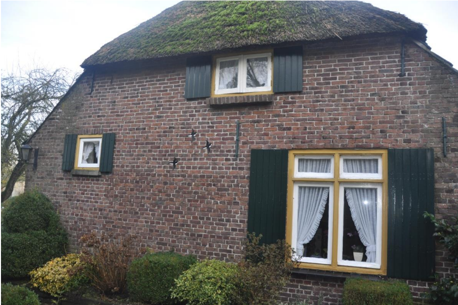
Afb. 11. Westgevel (kopgevel) woongedeelte.
