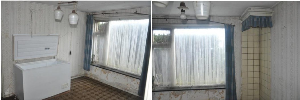
Afb. 48 en 49. woonkamer aangebouwde woning.
