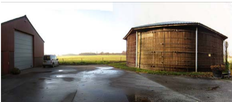
De te slopen mestilo
