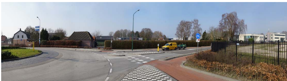
Het plangebied aan de Stökskesweg, rechts van het midden van de foto.
