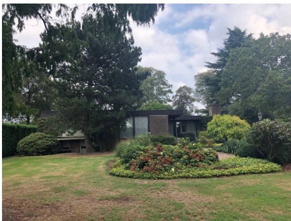
Zuid-West gevel bestaand.
