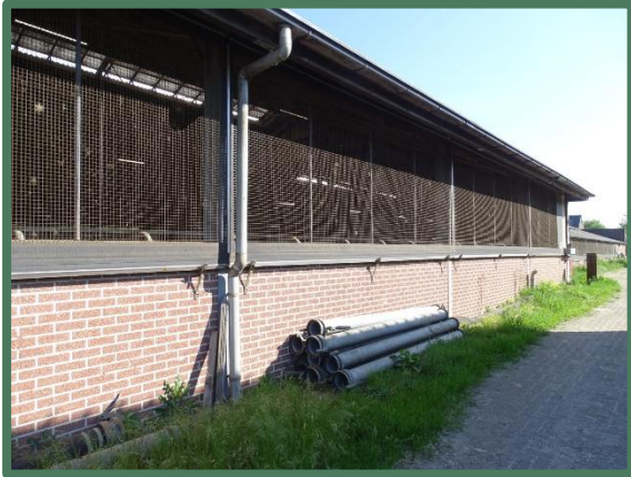
Foto 5: Overzicht wanden noordelijk gelegen stal
