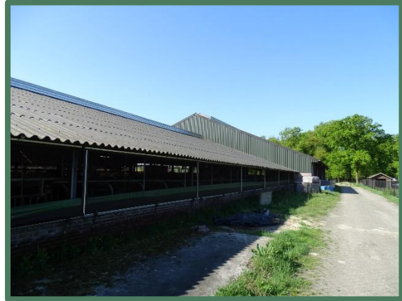
Foto 6: Overzicht wanden noordelijk gelegen stal
