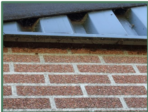
Foto 13: Aansluitende randen op de betonwanden
