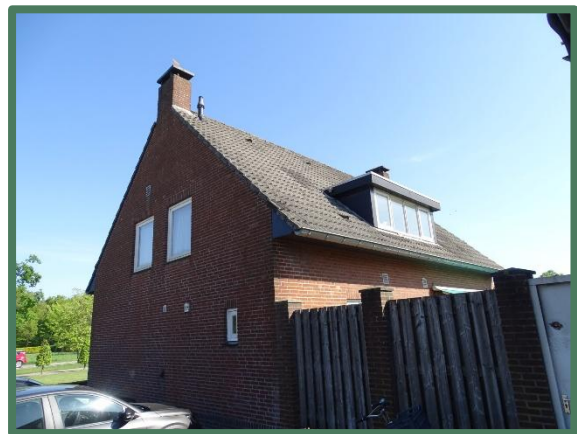
Foto 2: Overzicht woning vanuit zuiden
