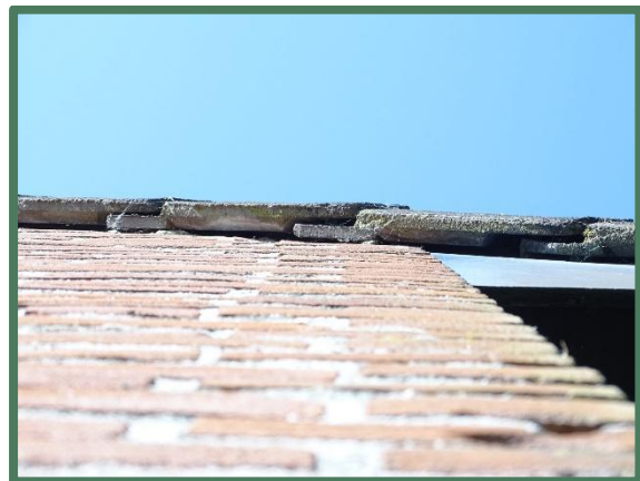
Foto 12: Ruimte achter kantpannen
