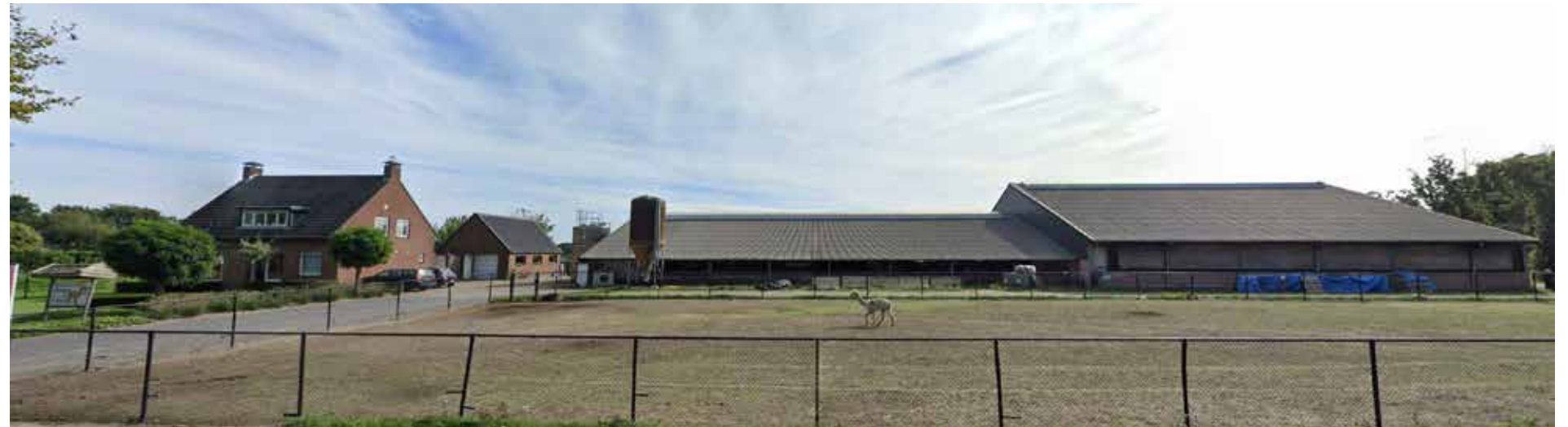
Straatbeeld B. Bron: Google street view
